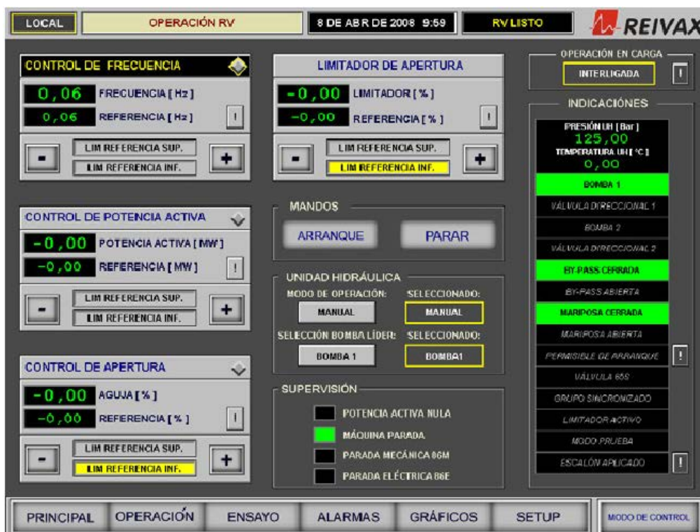
Figura 2. 20. Ejemplo de Pantalla de Operación e instrumentación (Central Los Chillos REIVAX).
