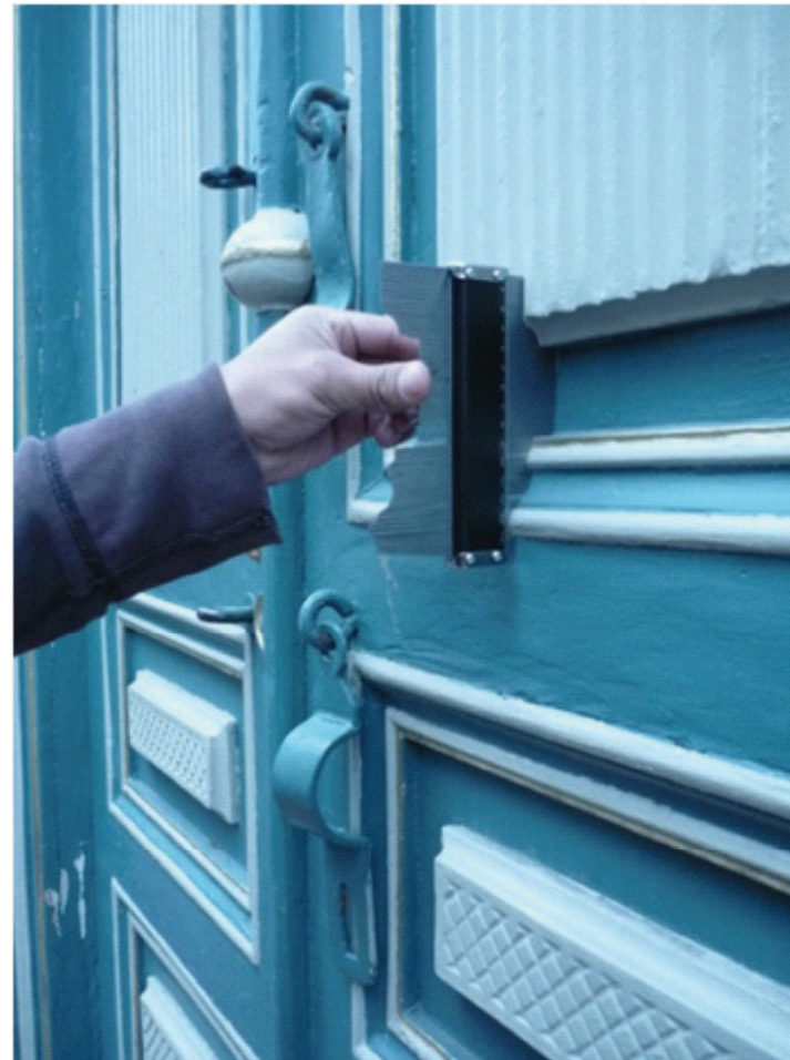
Fotografías del levantamiento de detalle con el perfilador en la casa Rodríguez, 2009
