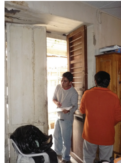
Apunte de daños y patología en la libreta de registro
