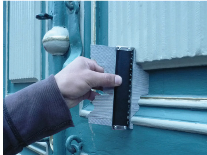
Levantamiento de detalles constructivos con perfilador.
