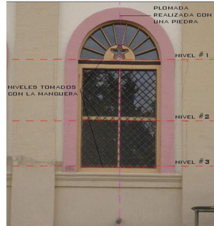
Fotografía del levantamiento de detalle con la plomada en la Casa de los Arcos, 2008
