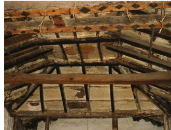
Fotografía de la estructura de la cubierta de la hacienda Valdivieso, 2008
