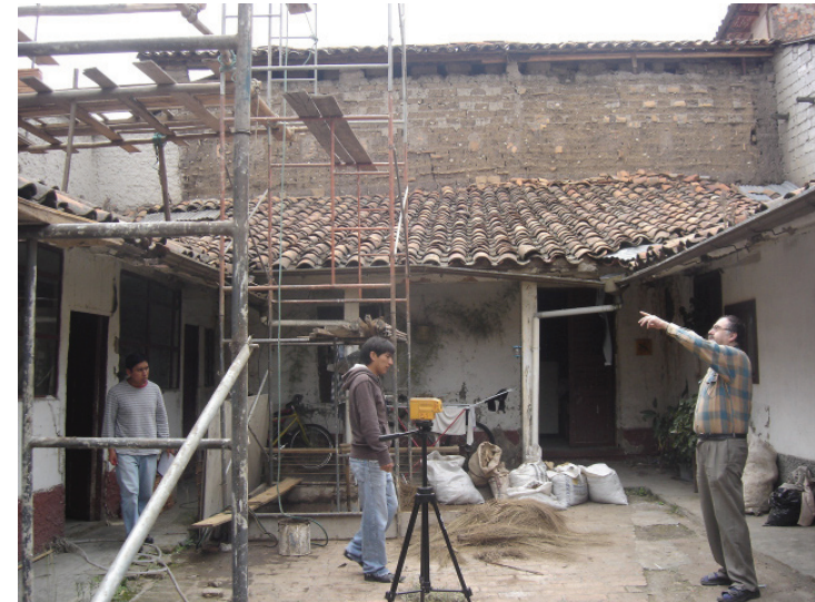
Proceso de nivelación con nivel digital.
