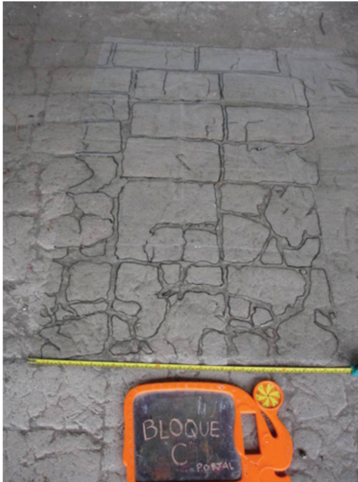
Fotografía del piso de la hacienda de Susudel donde se observa el levantamiento del detalle con el plástico, Decimo de Restauración, 2009
