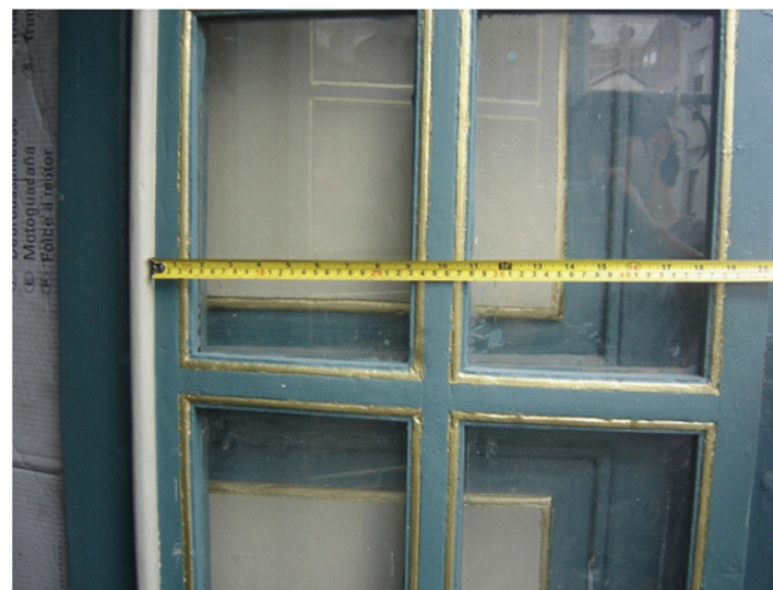
Fotografía utilizada para el dimensionamiento, casa Rodríguez, Cuenca 2010
