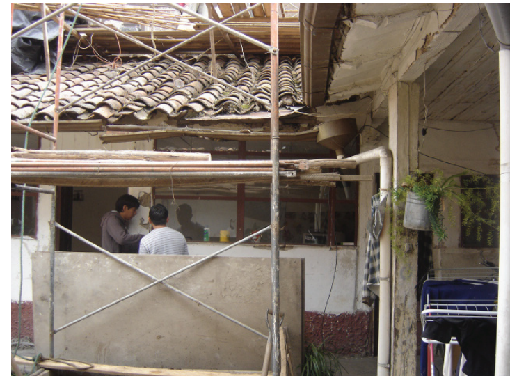
Levantamiento en planta con disto.
