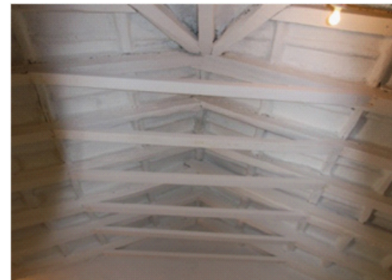
Fotografía de la estructura de la cubierta de la capilla de Susudel, 2008
