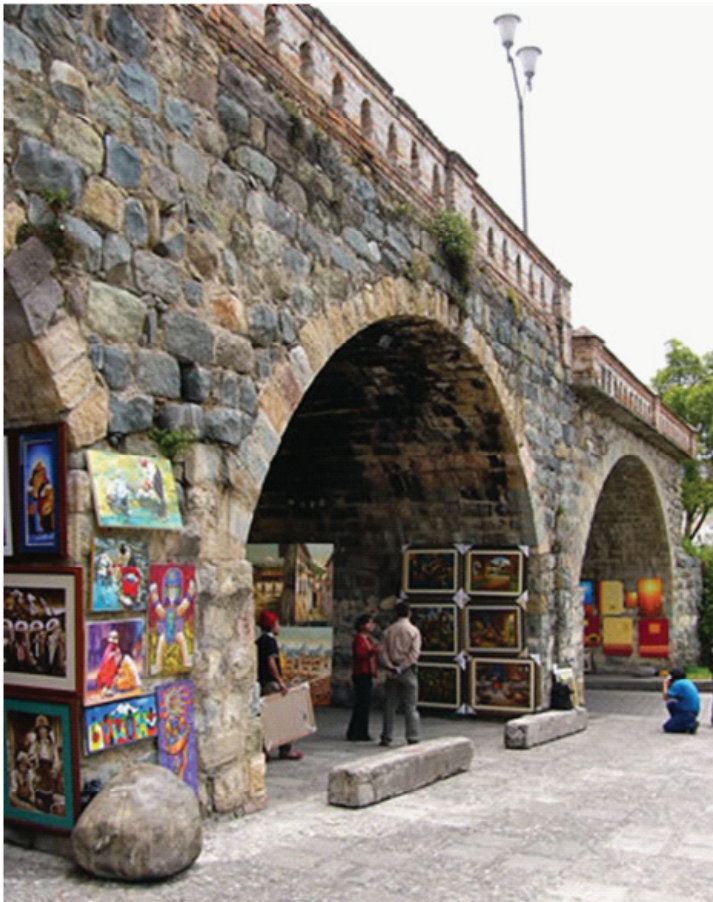
Puente Roto, Cuenca, 2006
