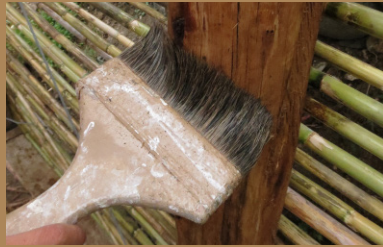
figura 49. Brocheado* Método de preservación
