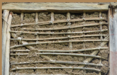
figura 107. Relleno de barro* Chordeleg - Azuay
