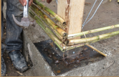
Figura 446. Carrizos iniciales* Armado de carrizo
