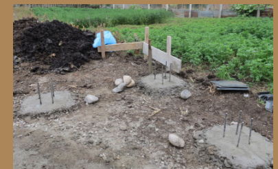
Figura 408. Cimiento fundido* Cimentación
