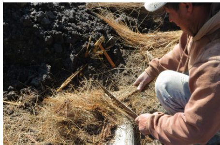
Figura 450. Corte de la paja* Revestimiento
