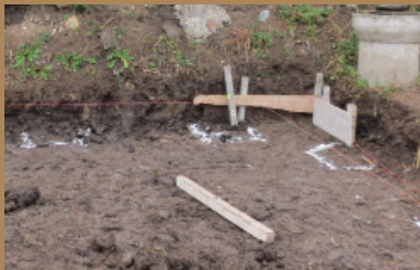
Figura 402. Trabillas* Cimentación
