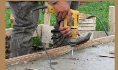
Figura 414. Perforación* Sobrecimiento
