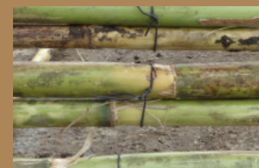
figura 232. Amarre con alambre* Aplicación
