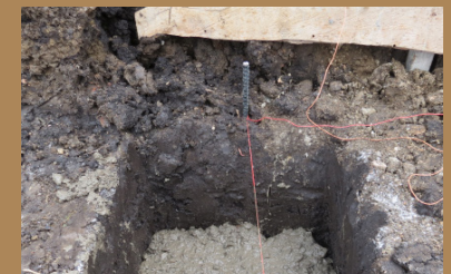
Figura 407. Relleno con hormigón* Cimentación
