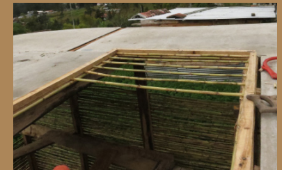
Figura 444. Carrizos en tragaluz* Cubierta
