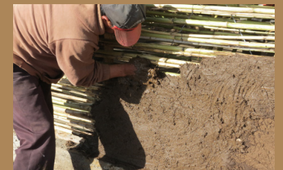
Figura 453. Embarrado* Revestimiento
