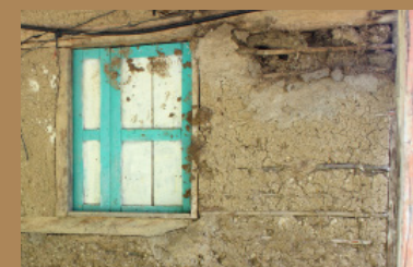
figura 143. Desmoronamiento* Paute - Azuay
