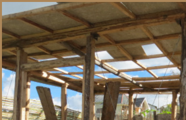
Figura 440. Colocación de planchas* Cubierta
