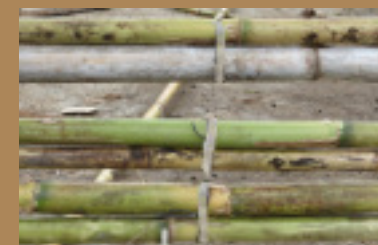
figura 234. Amarre con nylon* Aplicación
