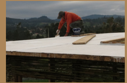
Figura 442. Impermeabilización* Cubierta
