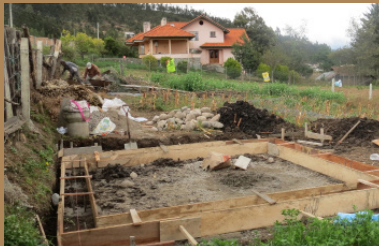
Figura 410. Encofrado* Sobrecimiento
