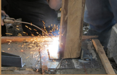
Figura 417. Angulos soldados* Estructura
