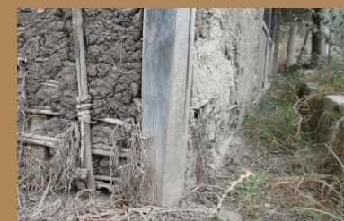
figura 135. Deformación inferior* Gualaceo - Azuay
