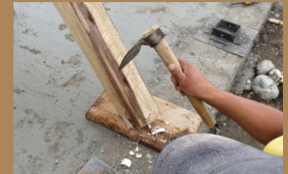
Figura 425. Destaje de pilares* Estructura
