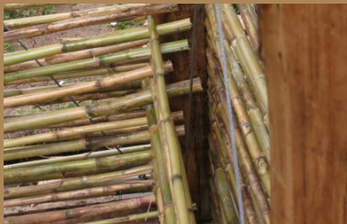
Figura 448. Cámara de aire* Armado de carrizo
