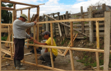
Figura 437. Armado de estructura* Cubierta
