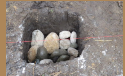
Figura 406. Relleno con piedra* Cimentación
