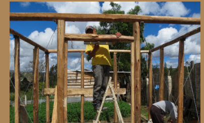
Figura 434. Clavado de dinteles* Estructura
