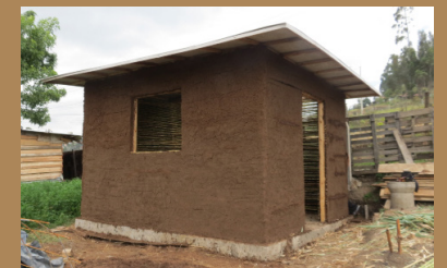
Figura 454. Modulo con barro* Revestimiento
