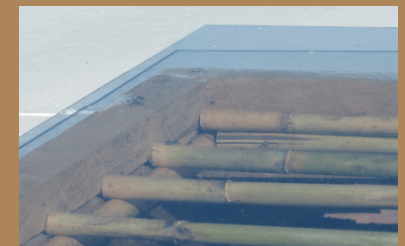
Figura 445. Colocación del vidrio* Cubierta
