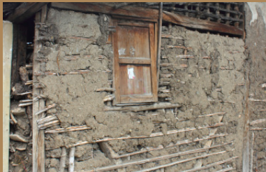
figura 123. Deformaciones* Chordeleg - Azuay
