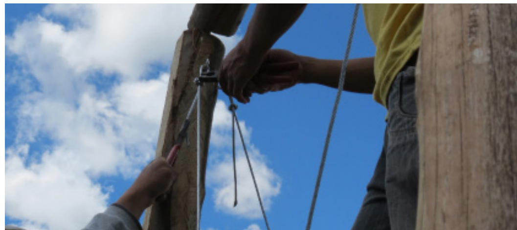
Figura 432. Tensores (cables de acero)* Estructura
