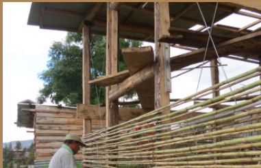
Figura 447. Pared exterior* Armado de carrizo
