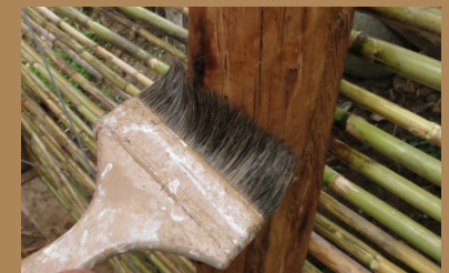
Figura 435. Impermeabilización* Preservación
