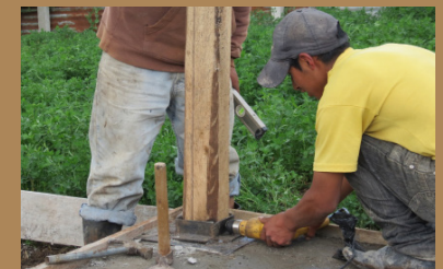
Figura 426. Perforación de pilares* Estructura
