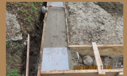
Figura 415. Colocación de placas* Sobrecimiento
