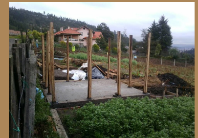
Figura 427. Colocación de pilares* Estructura
