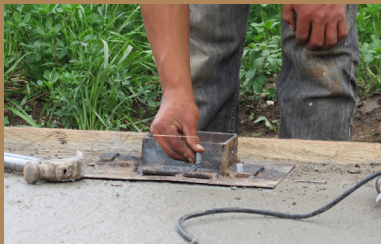
Figura 419. Colocación de taco fisher* Estructura
