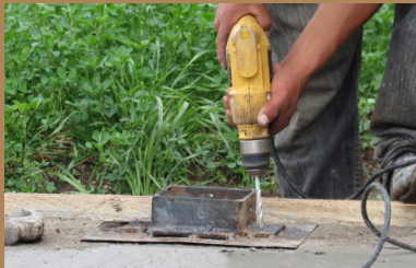
Figura 418. Perforación de ángulos* Estructura
