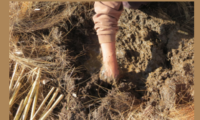
Figura 452. Mezclado manual* Revestimiento
