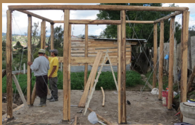
Figura 431. Colocación de soleras* Estructura
