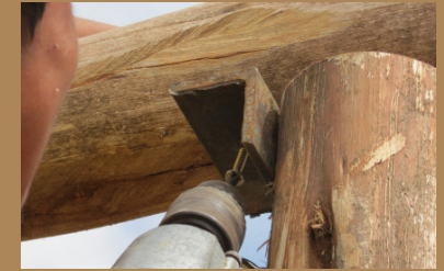
Figura 433. Colocación de ángulos* Estructura
