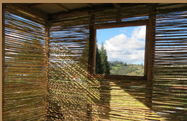
Figura 449. Pared interior* Armado de carrizo
