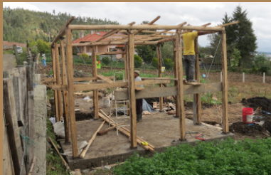
Figura 438. Montaje de estructura* Cubierta
