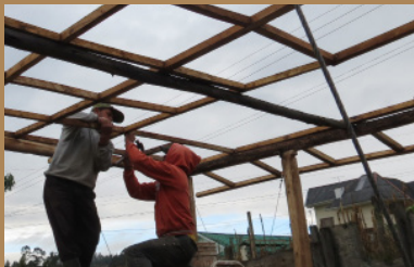
Figura 439. Conformación de tragaluz* Cubierta
