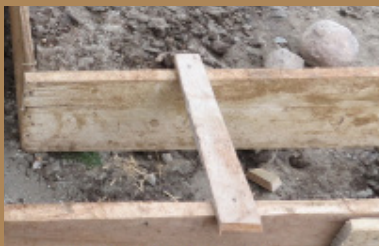
Figura 412. Apoyo horizontal* Sobrecimiento
