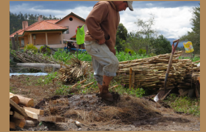
Figura 451. Batido del barro* Revestimiento
