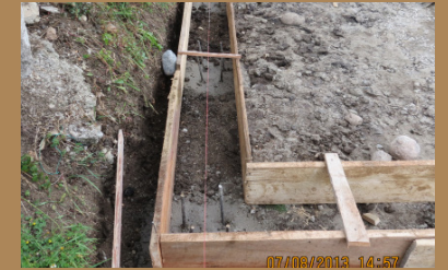
Figura 413. Encofrado* Sobrecimiento
