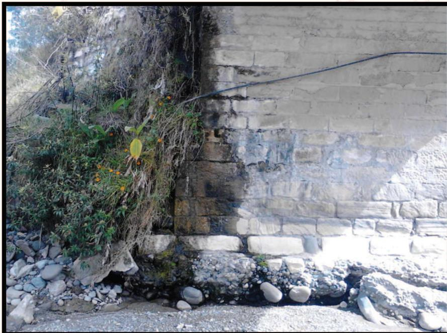
**Fotografía 29.** Estado de pila central derecha (en el cauce)
