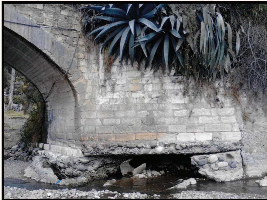
**Fotografía 27.** Estado del estribo derecho (en el lecho).
