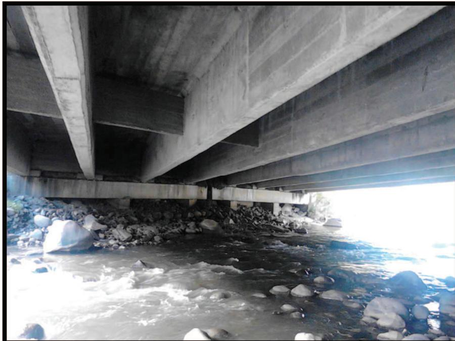
**Fotografía 14.** Degradación del material que existe tras las columnas del estribo izquierdo
