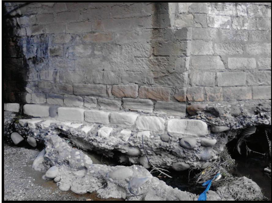
**Fotografía 28.** Estado del estribo derecho (aguas abajo).
