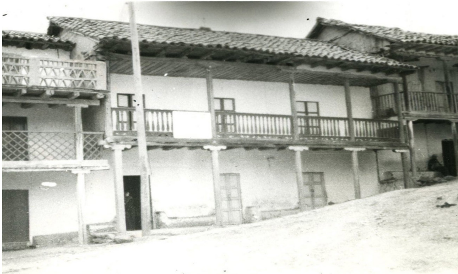
Figura 3. Vivienda de arquitectura vernácula. Fuente: CIDAP (1977).
