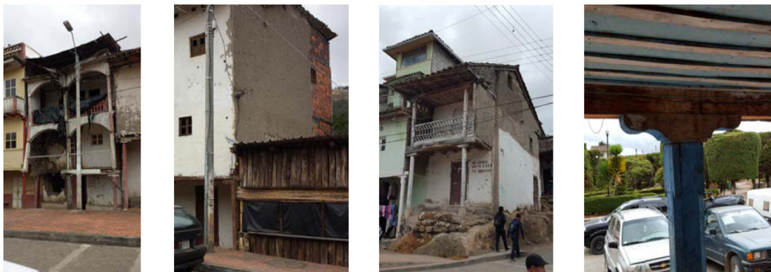
Figura 47. Daños en la parroquia de Quingeo. Fuente: Felix Troncoso (2019).
