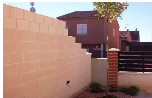
Muros de separación, muros de contención y cerramiento.
