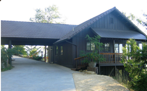
Garaje, aparcamiento y su camino y zona de maniobra si es necesario.
