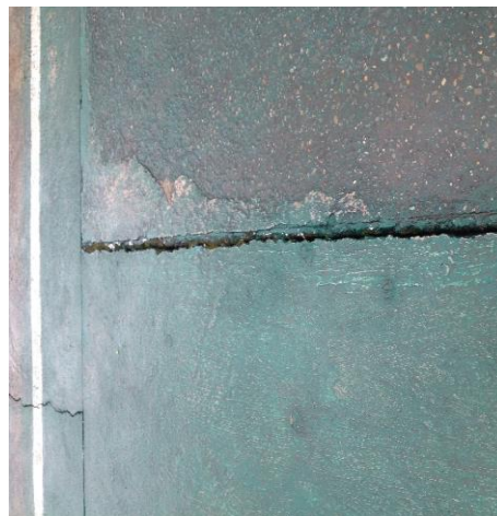
FOTO A7.1: Fisuras y grietas. A, B, D y E, fisuras en el Hospital y Coliseo del Campamento Guarumales. C, separación entre la pared y la vereda. F, separación entre la vía y la cuneta.
