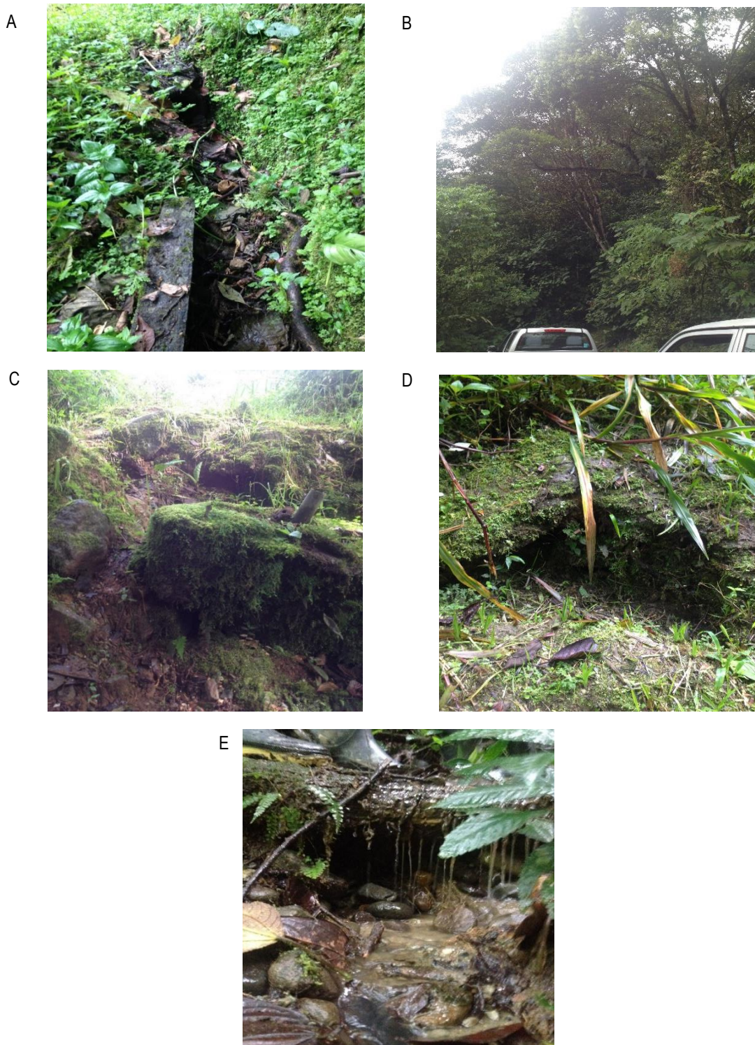
FOTO A7.3: A, D y E, socavación y fisuras debido a la presencia de acumulación de agua. B, árboles inclinados debido a probables asentamientos. C, movimientos de tierra críticos.
