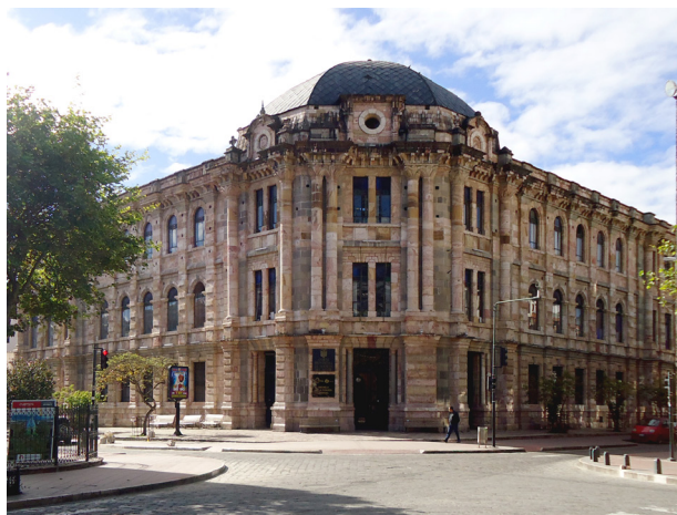
FIG. 27. Edificio de la corte Superior de Justicia (1929) edificación construida en ladrillo y recubierta con m rmar.
