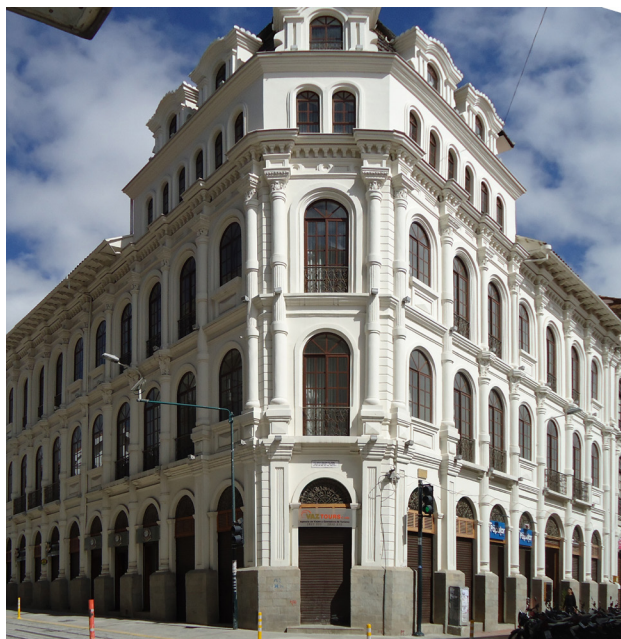
FIG. 86. Antigo Hotel Patria (1924). Durante el periodo de influencia neoclásica europea las construcciones, continuaron empleando el adobe como material para sus muros.
