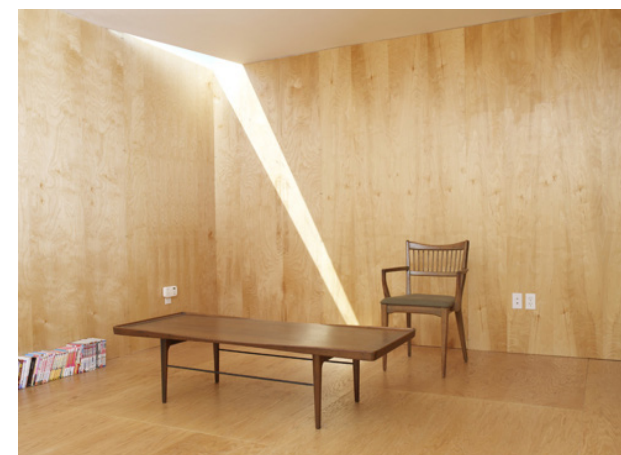
FIG. I27. Paredes divisorias con contrachapados de madera.
