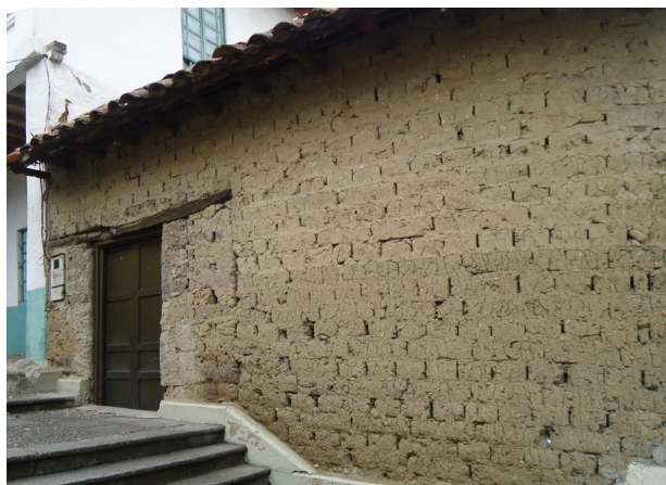
FIG. 87. Casa construida en adobe. este material siguió empleandose durante el siglo XX aún tras la llegada del ladrillo y el hormigón.
