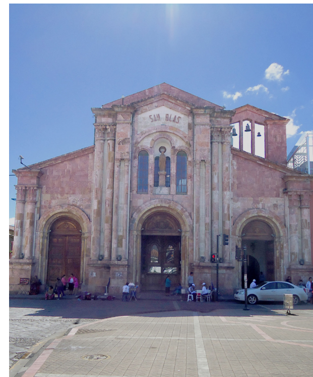
FIG. 29. Iglesia de San Blas (1557-1938) edificio reconstruido en 1938 y elaborado en m rmar travertino de Sayaus . El color rosa del este material hace que su fachada destaque notablemente.
