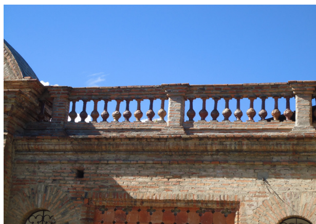
FIG. 64. Balaustres cerámicos entre pináculos de ladrillo en el edificio de la antigua escuela de medicina (1916)
