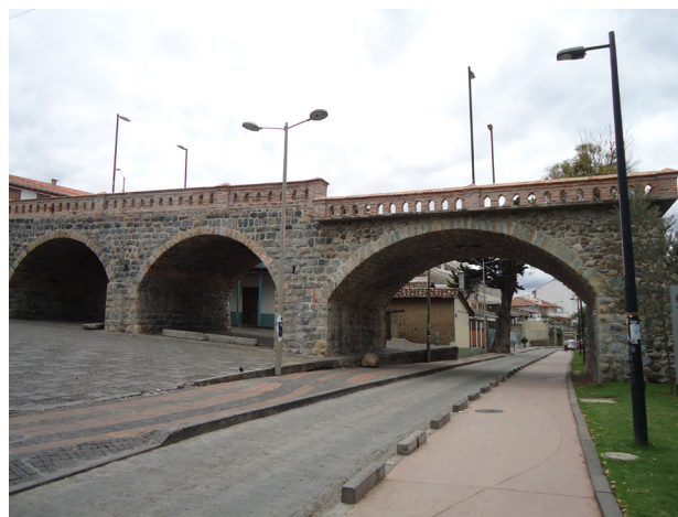
FIG. 40. Varias obras civiles como el puente roto fueron elaboradas haciendo uso de la piedra como material principal.
