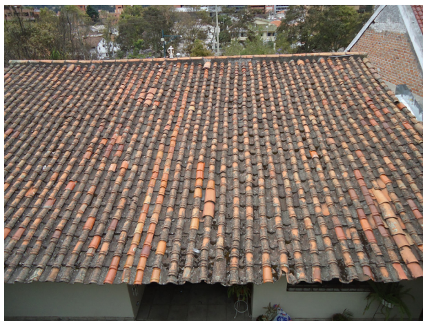
FIG. 68. La teja ha sido uno de los materiales principales para la conformación de cubiertas en las construcciones de la ciudad.
