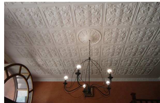
FIG. 73. Cielorraso de Estuco en la Casa Sojos.
