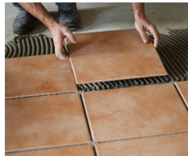
FIG. II2. Colocación de baldosas cerámicas
