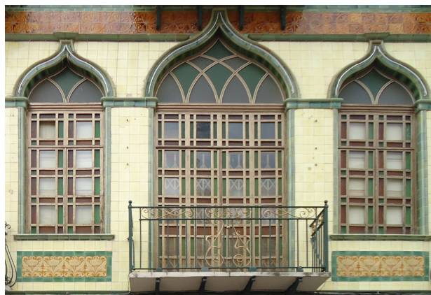
FIG.63. La variedad elementos ceramicos que conforman la fachada de la Casa de Loza, es una muestra de la riqueza expresiva que se podía lograr con este material.
