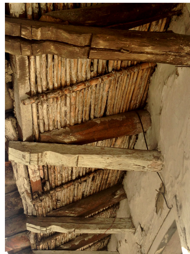
FIG. 80. El carrizo fue uno de los materiales más importantes para la conformación de cubiertas en las casas de la ciudad.
