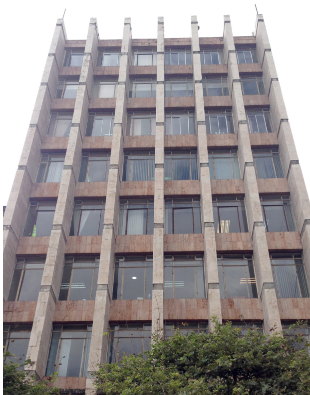
FIG. 81. Con la modernización de la arquitectura de la ciudad a partir de 1950, la inclusión del aluminio en ventanas y puertas se masificó de manera importante.
