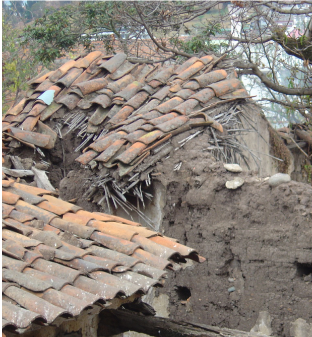
FIG. 14. Tejas, Suro y Adobes en la Casa de las Posadas. Estos elementos son materiales tradicionales íconos de la arquitectura de la ciudad.
