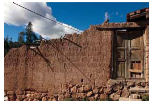
FIG. 131. Muro elaborado con bloques de adobe.
