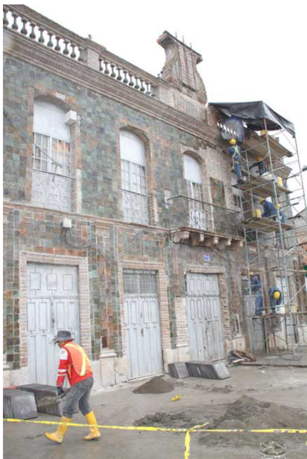
FIG. 93. Intervención en la casa de la Lira (2011). Es importante conocer las características técnicas de los materiales dentro de un bien patrimonial para realizar una intervención más adecuada.
