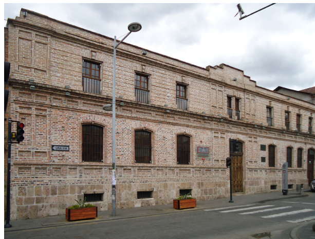
FIG. 24. La casa de Remigio Crespo (1886-1917) es un ejemplo notable del uso del ladrillo durante la época de auge económico de la Ciudad.
