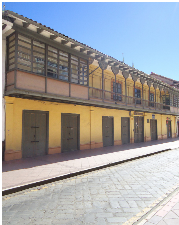
FIG. 75. Casa Episcopal (S. XVII). Ejemplo de uso de la hojalata. En el centro histórico, la gran mayoría de casas con canales y bajantes para aguas lluvia, estaban elaborados en hojalata.
