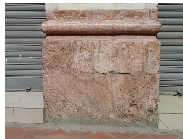
FIG. 101. Zócalo de mármol en edificio del centro histórico.
