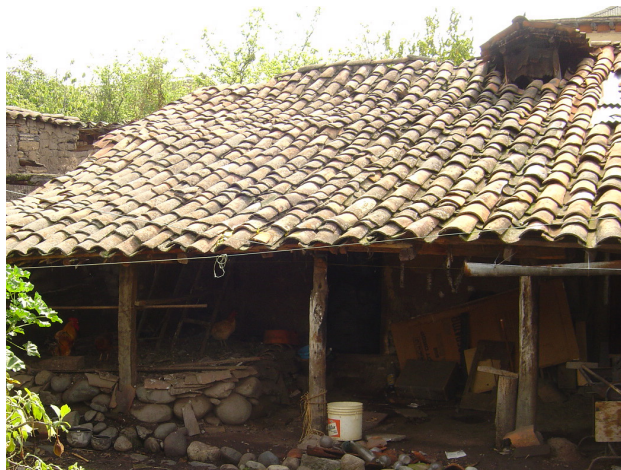
FIG. 40. Tejas de la cubierta de la crujía posterior de la Casa Colonial de las Posadas antes de su restauración.
