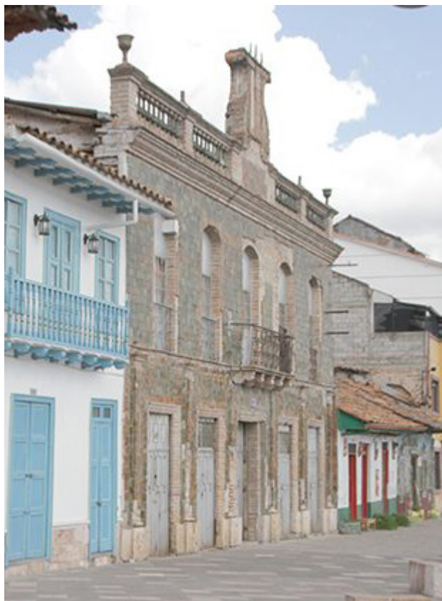
FIG. 62. Casa de la Lira. Esta edificación es un gran ejemplo del uso de piezas cerámicas vidriadas, en tonos terracota y esmeralda.
