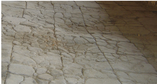
FIG. 6 Piso de ladrillo, Casa de las Posadas. En el proceso de restauración se aplicó la anastilosis para recuperarlos.
