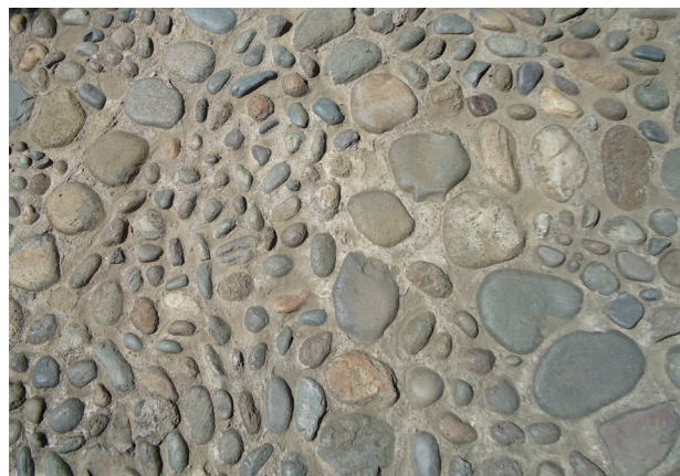
FIG. 39. El amorrillado de piedra fue muy usado como sistema para pisos de pasillos o portales exteriores en las casas de la ciudad.
