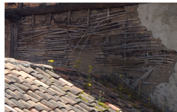
FIG. 90. El bahareque coexistió con el adobe desde la colonia, como sistema constructivo para las edificaciones de la ciudad.
