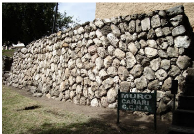
Fig. 32. Muro de piedra Cañari, Ruinas de Todos Santos en Cuenca. Las piedras tienen su forma natural en su mayoría y están unidos con argamasa de tierra negra y conforman un muro rectangular.
