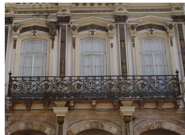
FIG. 109. Balcón con barandillas de hierro en el centro histórico de la ciudad
