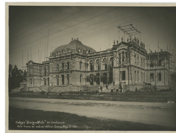
FIG. 19. Construcción del Colegio Benigno Malo en el año 1929
