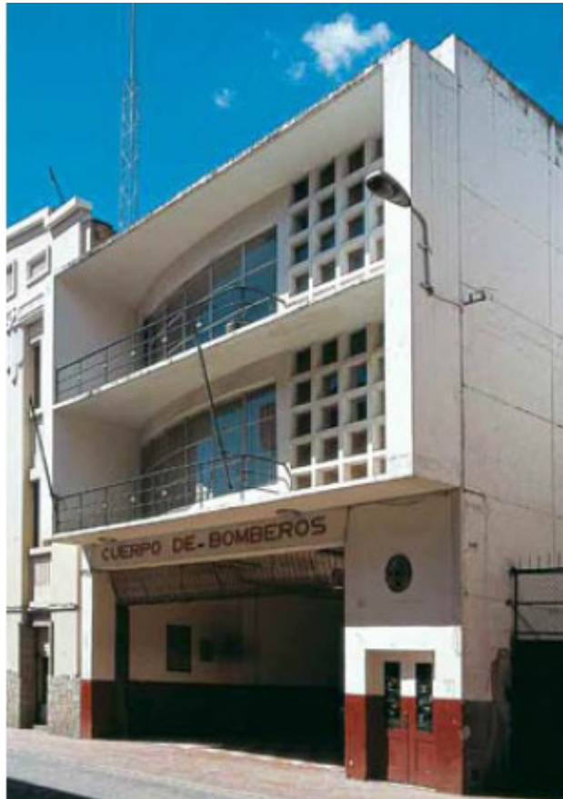
Fig. 11. Edificio de los Bomberos, se construyó entre los años 1948 -1957. Ejemplo de construcción en Hormigón Armado en el Centro Histórico.
