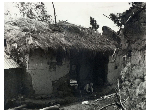
FIG. 39. No se conoce la precedencia de la fotografía, pero constituye un ejemplo muy aproximado de la Arquitectura Colonial Temprana en la ciudad de Cuenca.
