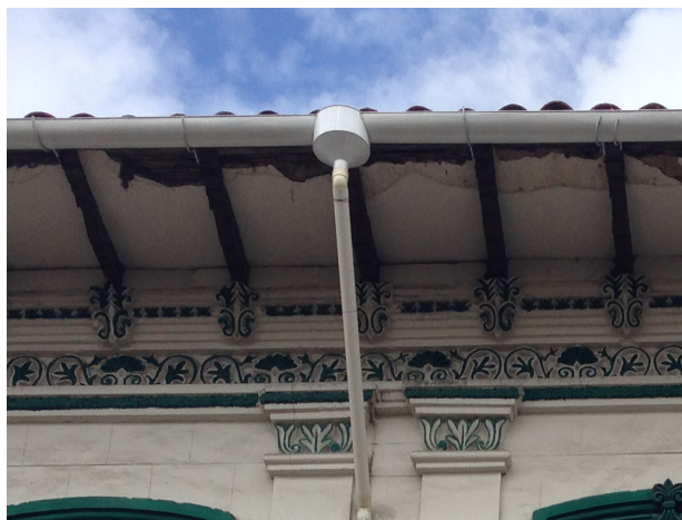
FIG. 76. La hojalata fue incorporándose en las construcciones para elaborar canales y bajantes de aguas lluvias.
