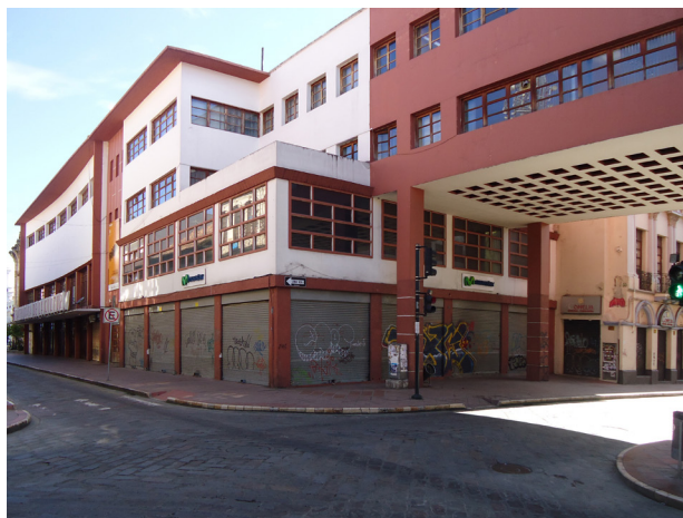
FIG. 43. Edificio de la Casa de la Cultura Ecuatoriana Núcleo del Azuay (1954)
