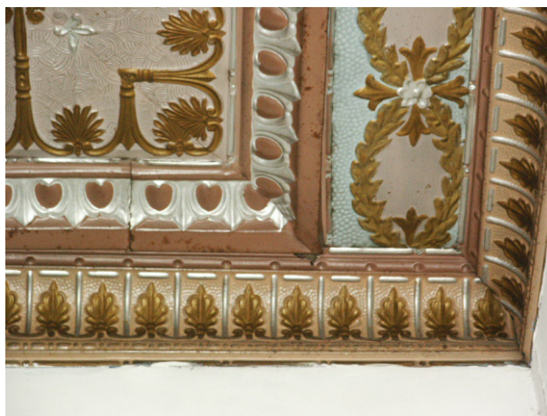
FIG. 47. El latón de marca Berloy fue de uso muy frecuente en las edificaciones del centro histórico. Las purpurinas que dan color a estos elementos brindan al latón, notable elegancia.
