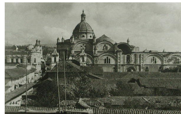
FIG. 20. La nueva Catedral de Cuenca en Construcción
