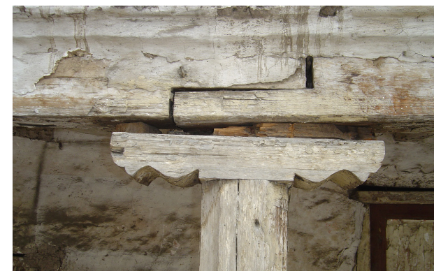
FIG. 41. Detalle Constructivo en madera, Casa de las Posadas, Cuenca. Uno de los pocos ejemplos de arquitectura colonial de la ciudad que data de 1760, muestra de alguna manera las costumbres constructivas con este material.
