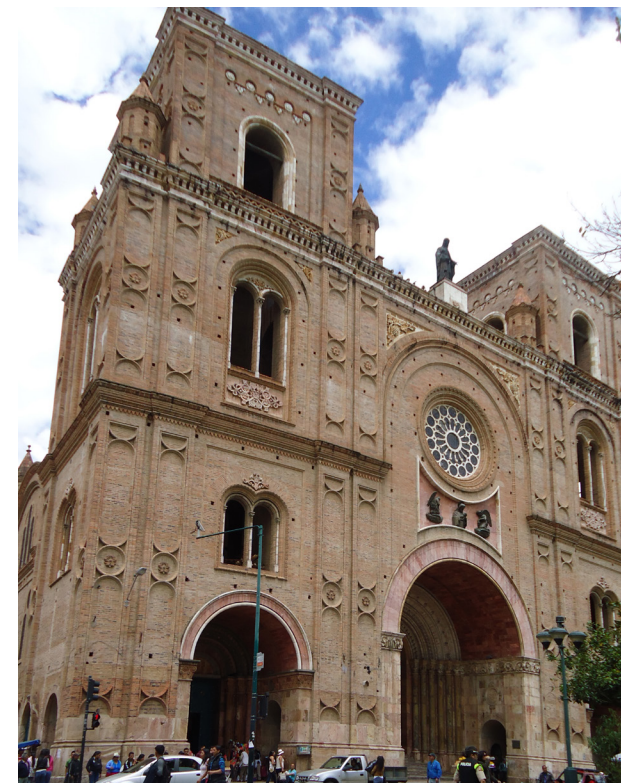
FIG. 22. La catedral de Cuenca, uno de las obras mas grandes que inició el siglo XIX usó el ladrillo como material principal.
