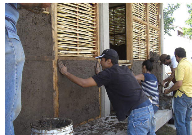
FIG. I33. Elaboración de un muro de bahareque.
