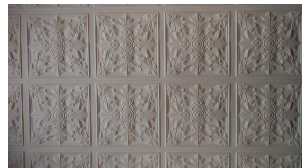
FIG. 74. anteriormente se usaban las placas de latón como moldes para la elaboración de estucos con lo cual, quedaban plasmados los relieves y detalles sobre este material.
