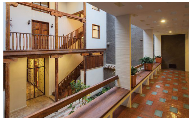
Fig. 13. Casa Juan Jaramillo, centro de Cuenca. Incorporación del acero en la concepción de la nueva arquitectura.
