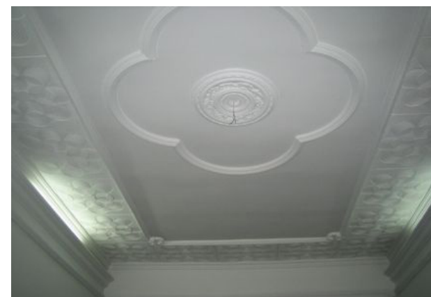
FIG. I17. Cielorraso de estuco.
