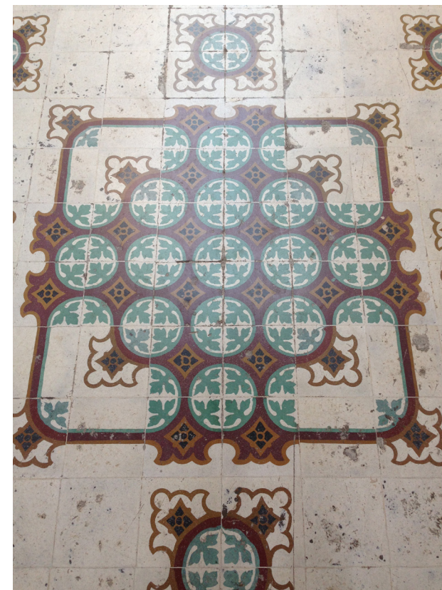
FIG. 61. Piso cerámico del edificio Pasaje León, ejemplo importante del uso de cerámica en edificaciones patrimoniales dentro de la ciudad
