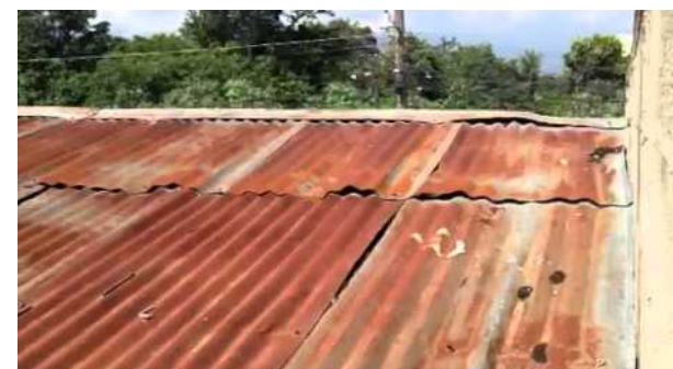
FIG. II5. Cubierta con planchas de zinc.
