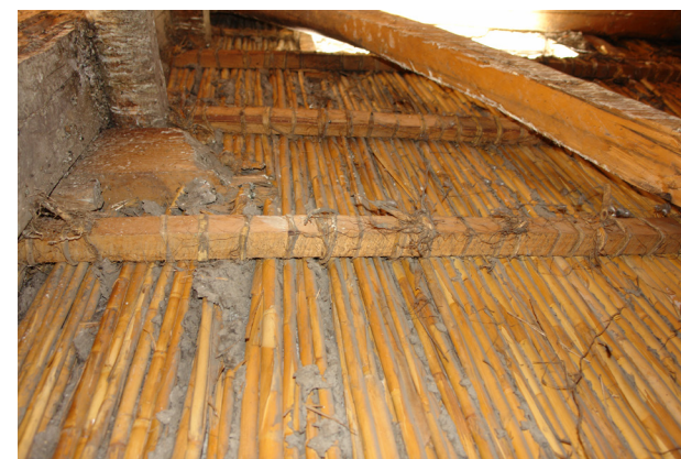
FIG. 121. Cielorraso de barro con carrizo en edificio patrimonial de Cuenca.
