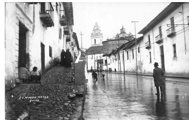
Fig. 25. Arquitectura Colonial Quiteña, s.a.
