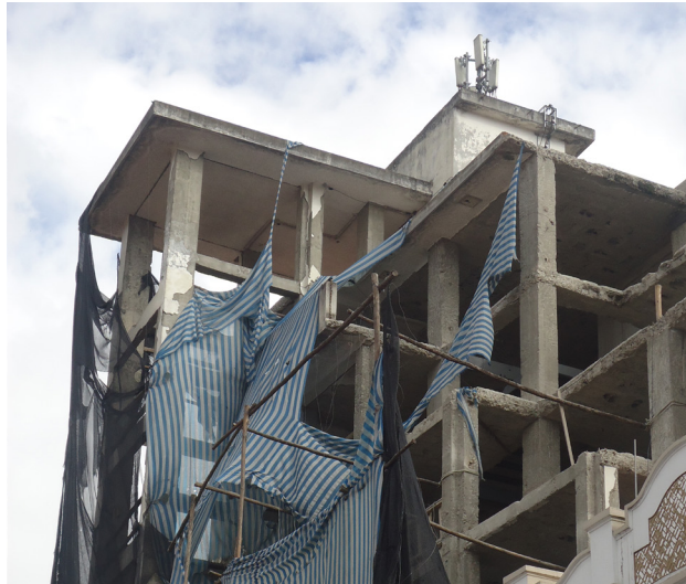
FIG. 17. Ejemplo de un edificio de Hormigón Armado, Hotel Escuela de la Universidad de Cuenca, muestra de las nuevas construcciones que se realizan en el Centro Histórico Cuenca.
