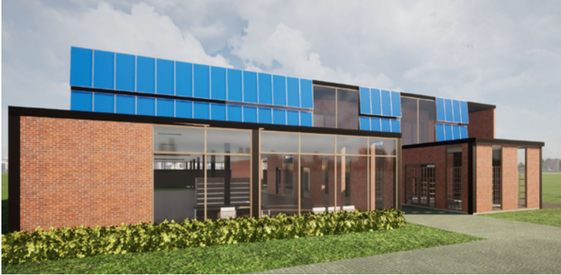
Figura 50. Paneles fotovoltaicos en fachada de escuela Fuente [elaboración propia]
