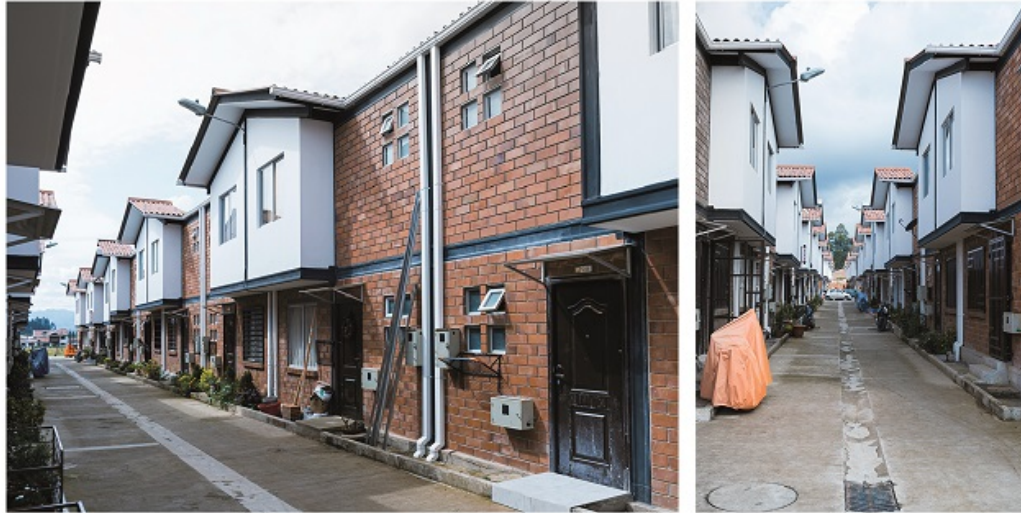
Figura 4. Estado actual de la vivienda de estudio en 2020
