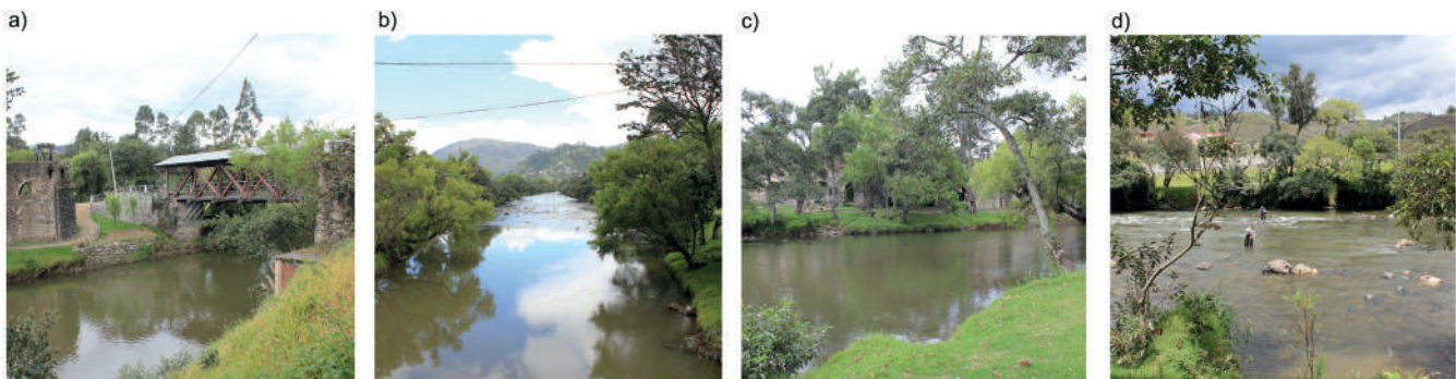
Figura 2. Fotografías de las áreas circundantes al puente P1: a) puente; b) vista aguas abajo desde P1, al fondo se divisa P2; c) y d) sección aguas abajo de P1. Fotografías de Timbe, abril de 2013.
