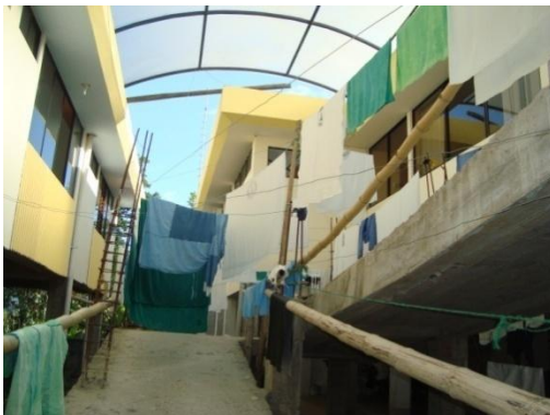
FOTO 3.2.3.3.A. Rampas En El Área De Lavandería
