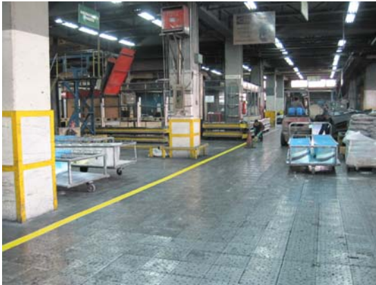
Fig.3.1 Trabajos de pintado en el área.
