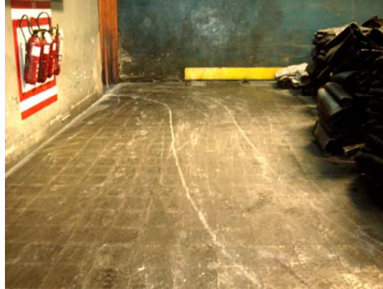
Fig.2.8 Marcas en el piso por derrames de pigmentos.
