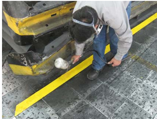
Fig.3.7 Aplicación de laca protectora sobre la pintura.
