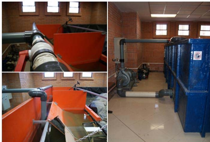
Figura 3.3.1: Infraestructura del Laboratorio de Dinámica de Fluidos PROMAS – Universidad de Cuenca
