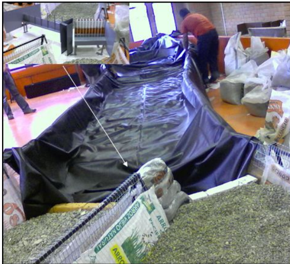
(c) Estructuras y colocación de geomembrana
