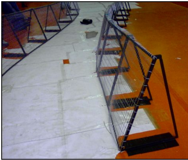
(a) Colocación de diques
