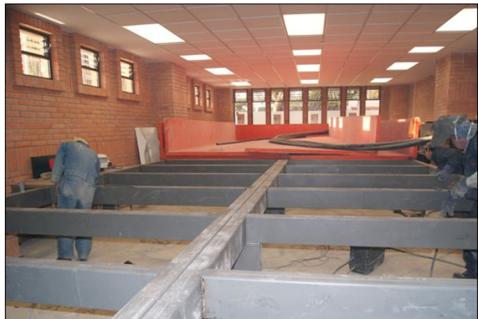
(b) Construcción de la estructura de soporte
