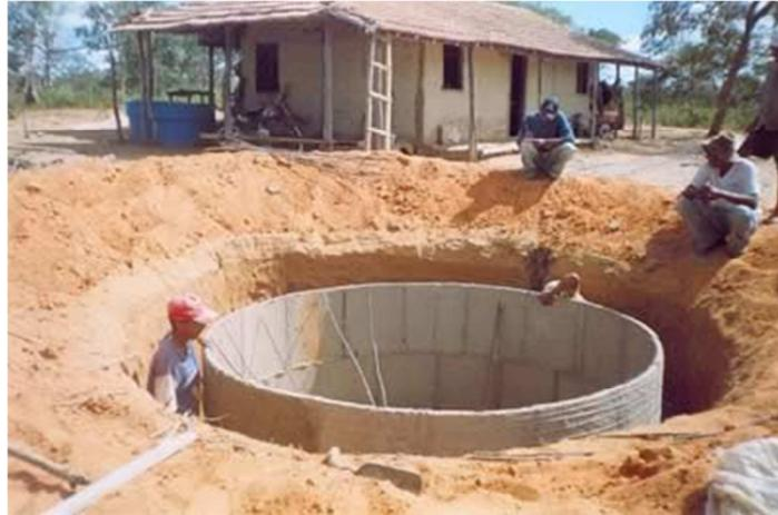
*Figura 9 Tanque enterrado en construcción.*
