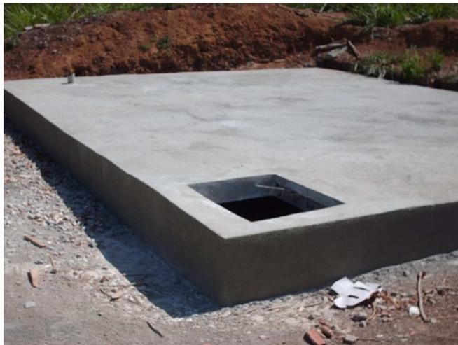
*Figura 6 Estanque cerrado en construcción.*
