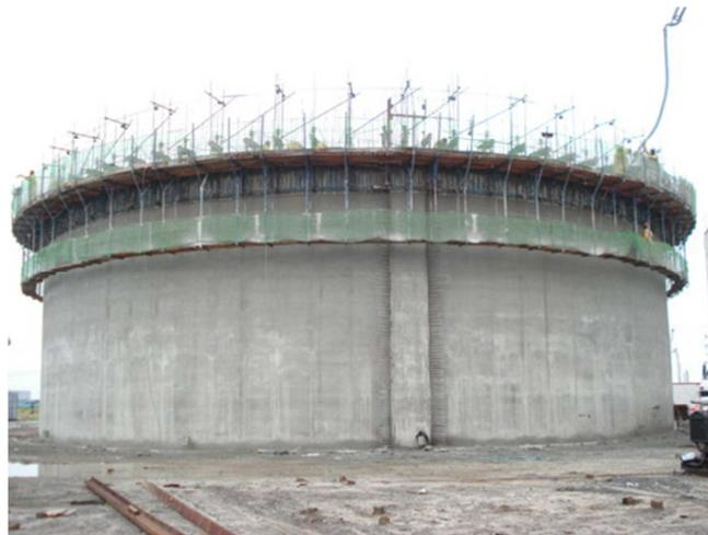
Figura 4 Tanque de reserva de hormigón armado.
