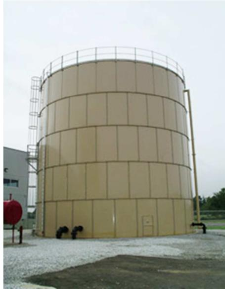
*Figura 2 Tanque de agua de reserva para incendios.*
