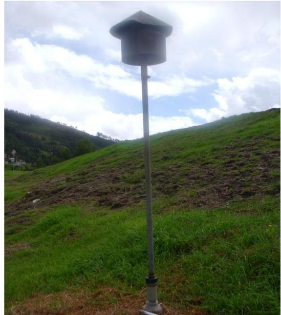
Fotografía 28: Ducto para la salida del biogás. Fotografía 29: Caseta de incineración del biogás
