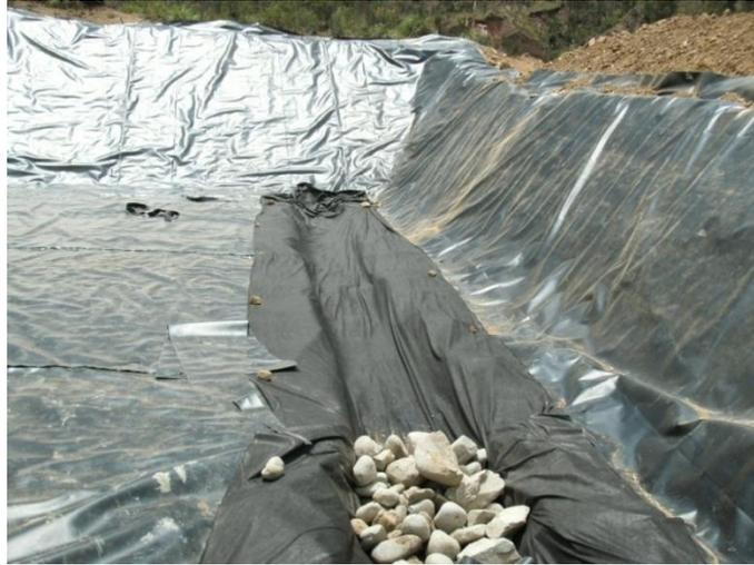
Fotografía 22: Impermeabilización del suelo de soporte
