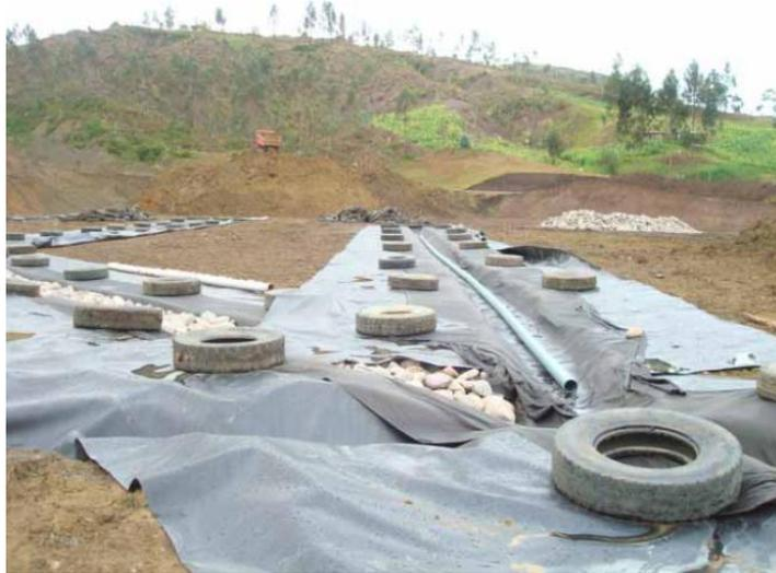
Fotografía 5: Impermeabilización y construcción del sistema de drenaje para lixiviados en Pichacay
