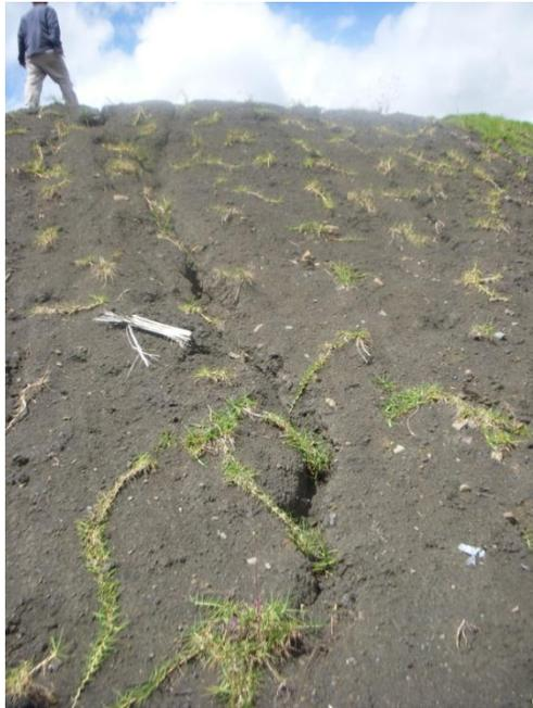
Fotografía 24: Erosión del talud por la escorrentía
