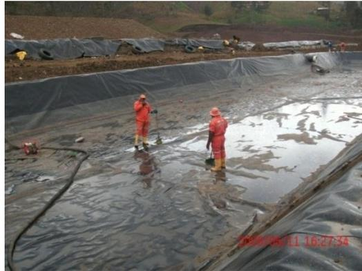
Fotografía 27: Impermeabilización del tanque para los lixiviados.
