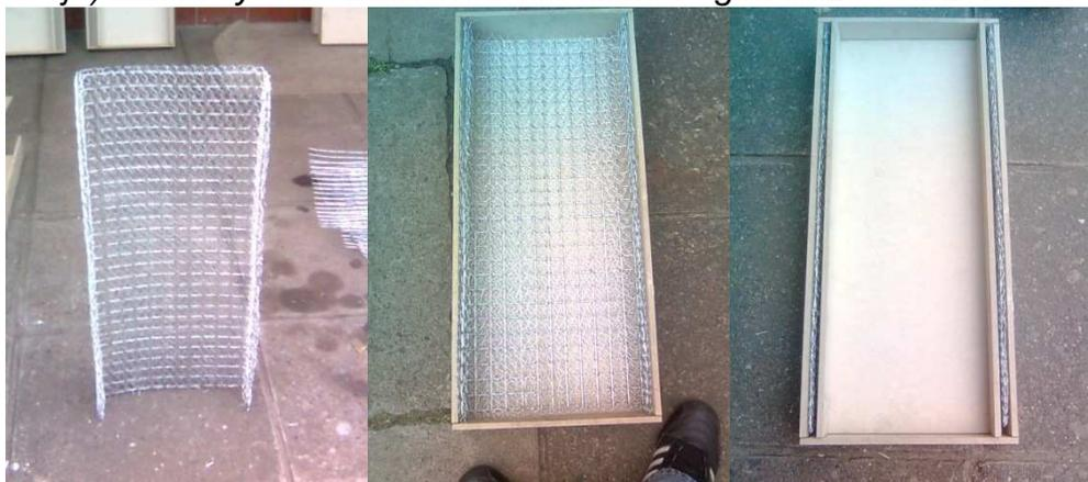
*Se finaliza comprobando que la armadura no tenga problemas de medidas, amarres y / o colocación en el cofre.*
