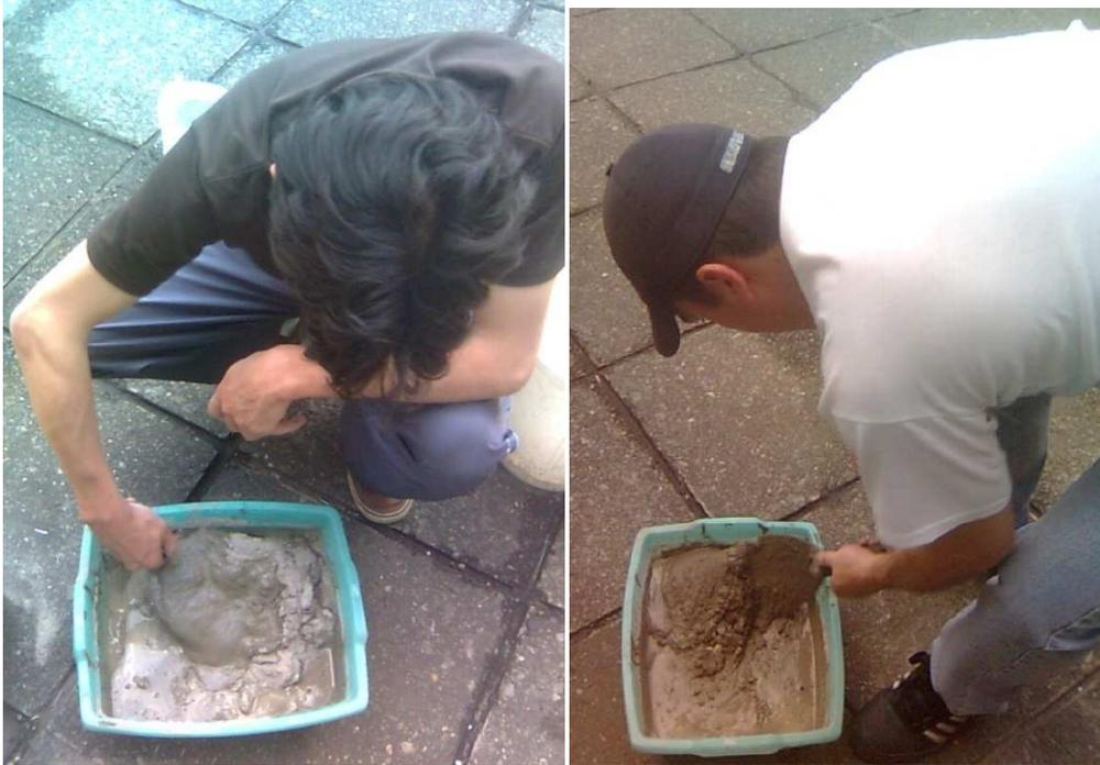
*Se mezcla cemento, arena y agua, de acuerdo al diseño del mortero para obtener la resistencia esperada.*
