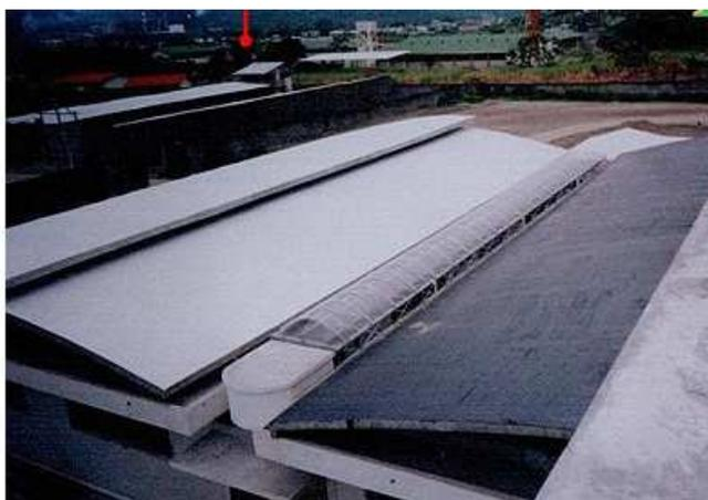
*Figura 8. Cubierta de placa plegada en ferrocemento.
