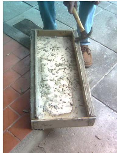
*Se procedió a golpear suavemente las paredes para que el cofre no se quede pegado en la sección.*
