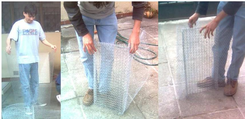
*Se coloca las 4 mallas hexagonale alrededor de la soldada (2 arriba y 2 abajo) con la ayuda de amarres con alambre galvanizado # 20.*
