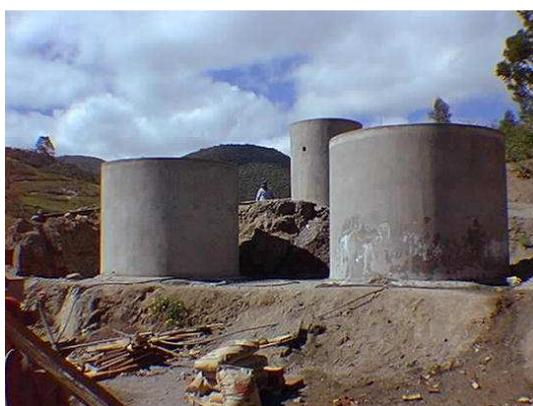
*Figura 7. Tanques de ferrocemento en Ecuador. [www.ferrocement.com]*
