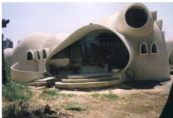
*Figura 21. Vivienda poco convencional construida en ferrocemento.
