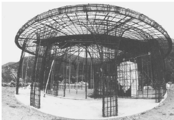
Figura 19. Acero de armazón para una estructura de ferrocemento.
