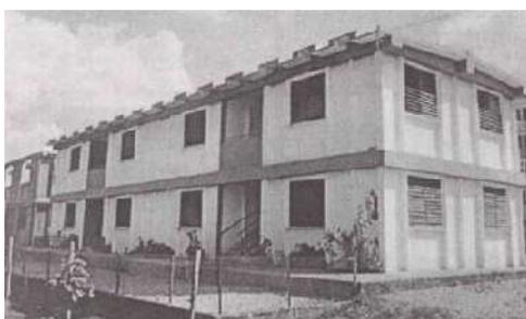
*Figura 14. Viviendas de uno y dos pisos en ferrocemento. [Naaman, 2000]*
