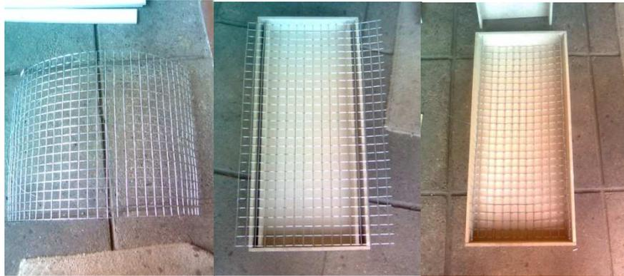
*Se corta la malla soldada a medida y se dobla de tal forma que cumpla con las dimensiones establecidas en el diseño, esta actuará como el esqueleto para la armadura.*
