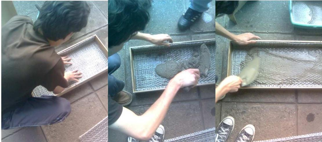
*Se coloca acontinuacion la armadura y se cubre con la mezcla hasta cumplir con el recubrimiento.*
