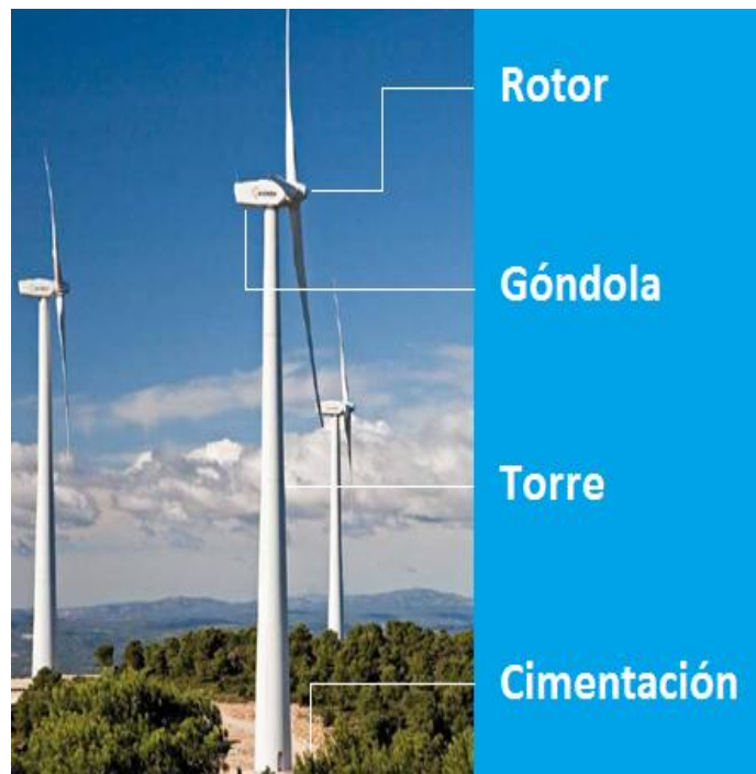
Figura 3. 6 Sistema eólico de gran potencia
