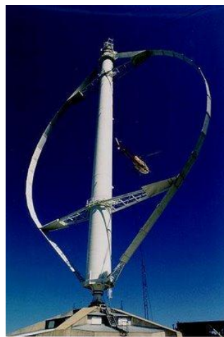
Figura 3.4 Aerogenerador de Eje Vertical (Darrieus)
