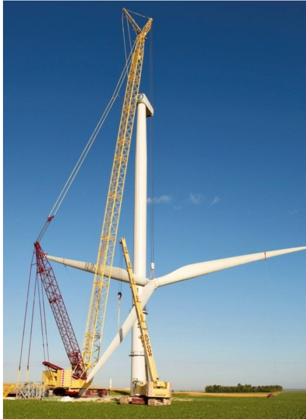
Figura 3. 14 Rotor con las aspas mientras es montado a la torre
