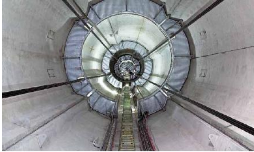
Figura 3. 10 Escalera de acceso al interior de una torre
