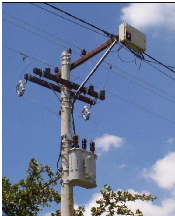
Figura 3.28. Red con montaje integral
