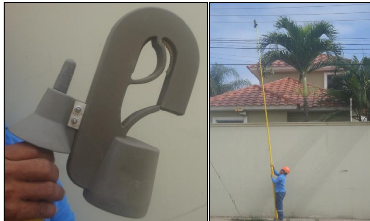
Figura 3.22. Instalación Varcorders
