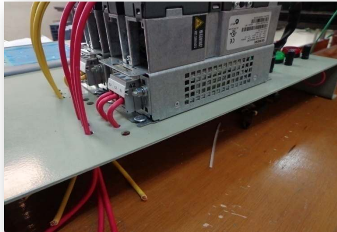
FIG.134 Montaje de los filtros para el motor
