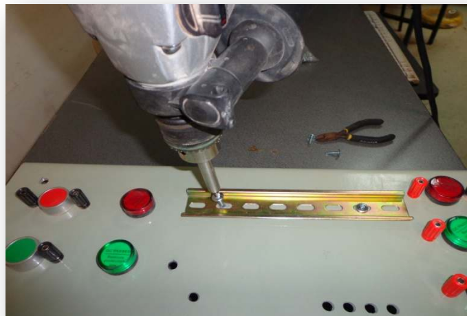
FIG.127 Montaje del Riel Din
