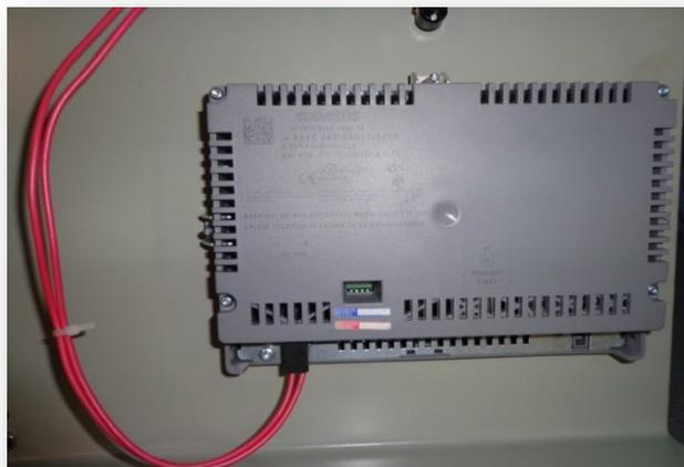
**FIG.140** Conexión de la alimentación de los HMI'S
