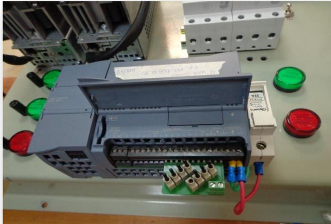
**FIG.131** Montaje de los PLC's S7-1200 y Switch
