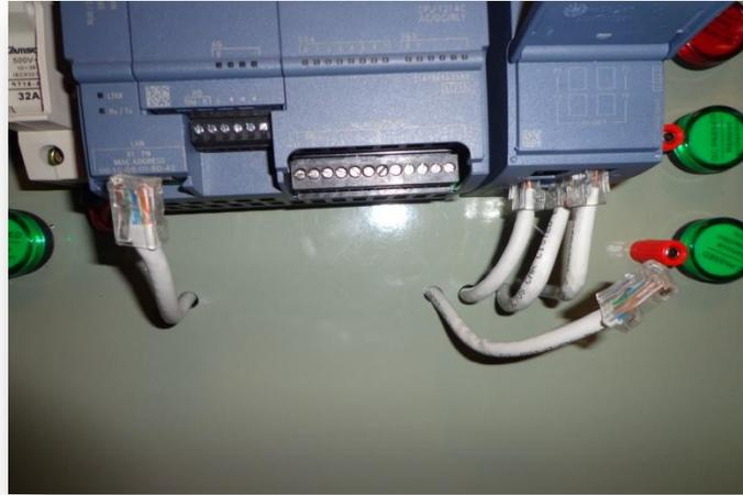
**FIG.141** Conexión del cable Ethernet en los puertos RJ45 de los dispositivos
