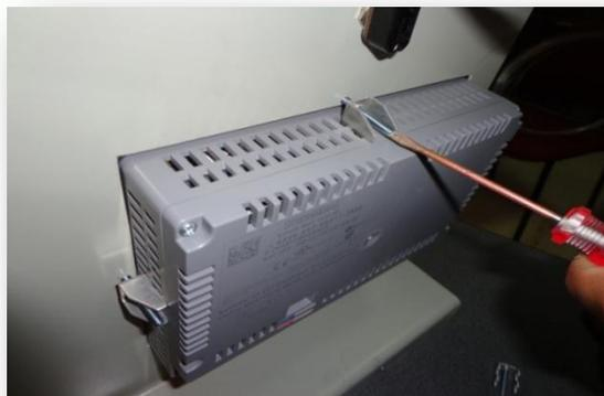
**FIG.130** Montaje de los HMI's KTP600
