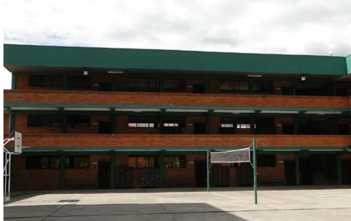
Figura 4.20: Bloque C del Colegio
