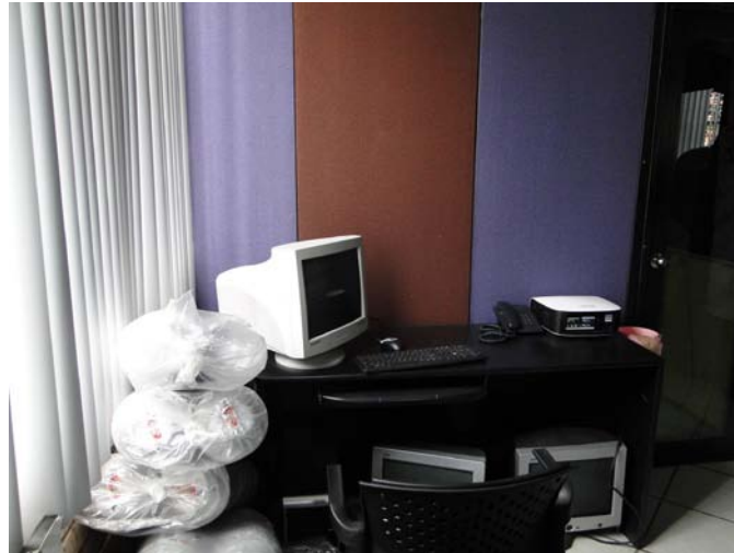
Figura 4.12: Espacio destinado al monitoreo de los servidores
