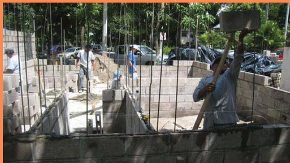
FOTO 1.35: Construcción con bloques de Suelocemento.
