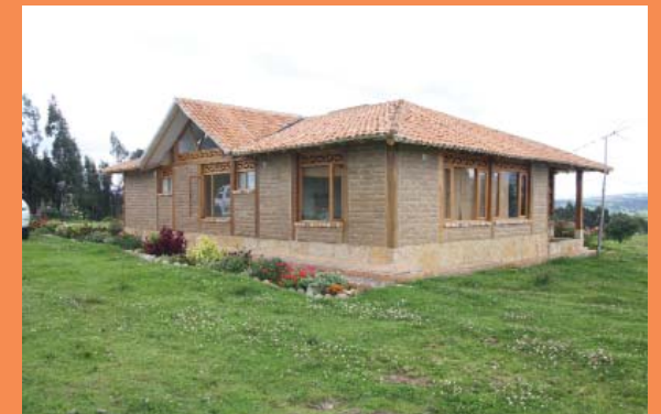
FOTO 1.37: Casa de adobe.
