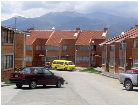
FOTOGRAFÍA 2.2: Vía local y parqueaderos internos de la urbanización.
