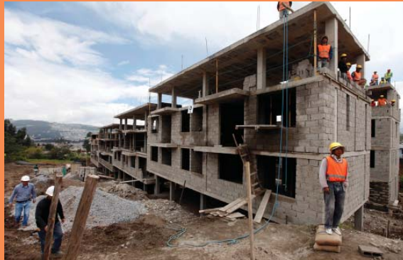
FOTO 1.31: Construcción de Viviendas.
