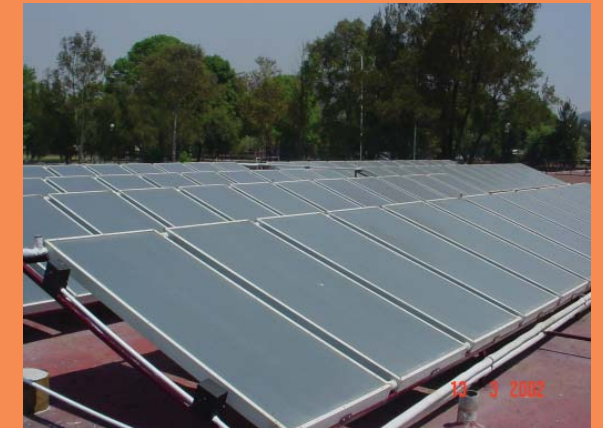
FOTO 1.20: Calentadores solares.
