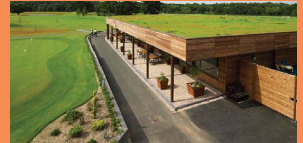
FOTO 1.15: Techo verde, materiales aislantes.
