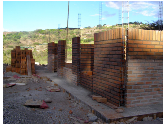
FOTOGRAFÍA 3.42: Utilización de Ladrillo Artesanal elaborado en Santa Isabel.
