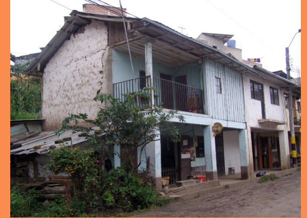
FOTO 3.23: Edificaciones del sector
