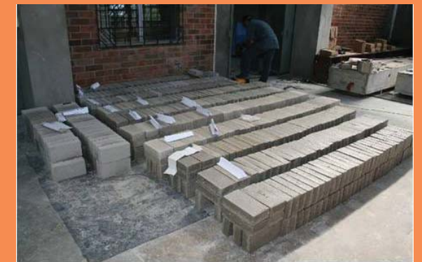
FOTO 1.34: Bloques de Suelocemento.
