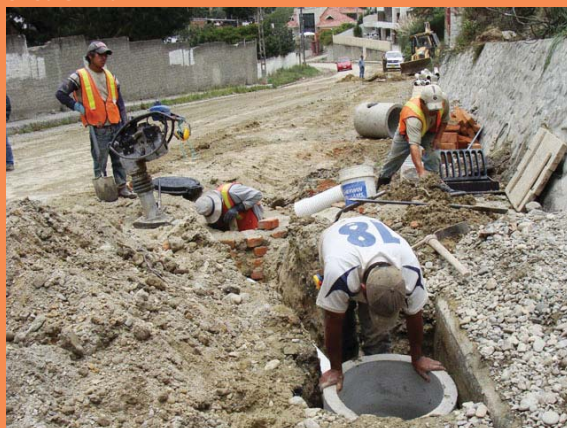
FOTO 1.44: Obras de Alcantarillado realizadas gracias a los GADs.
