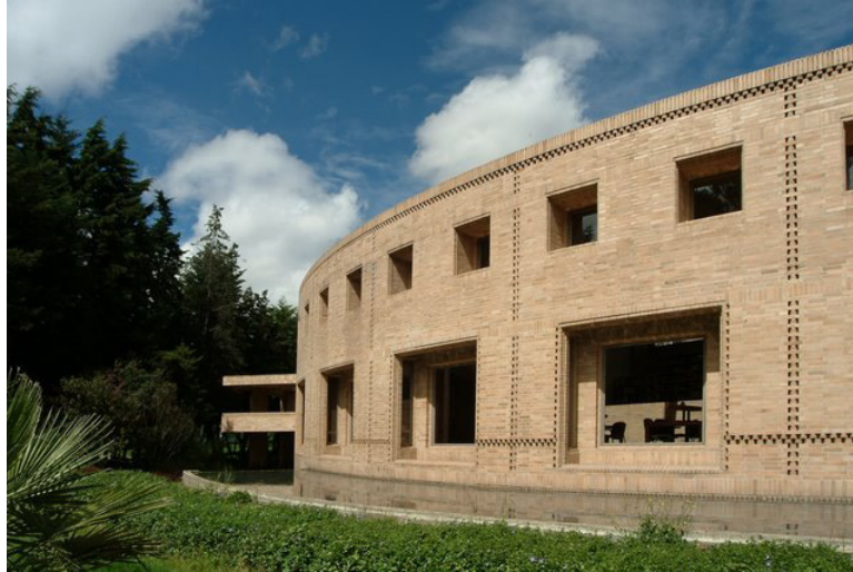
EXTERIOR DEL EDIFICIO DE POSGRADOS DE CIENCIAS HUMANAS. UNIVERSIDAD NACIONAL. Fuente: Fundación Rogelio Salmona.
