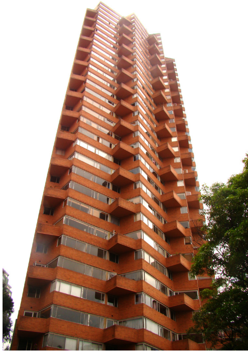
TORRE A, TORRE CENTRO DEL CONJUNTO DE LAS TORRES DEL PARQUE.
