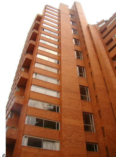
Foto No. 4.6: Vista Lateral de Torre B de las "Torres del Parque". Tomada por: Santiago Sánchez.
