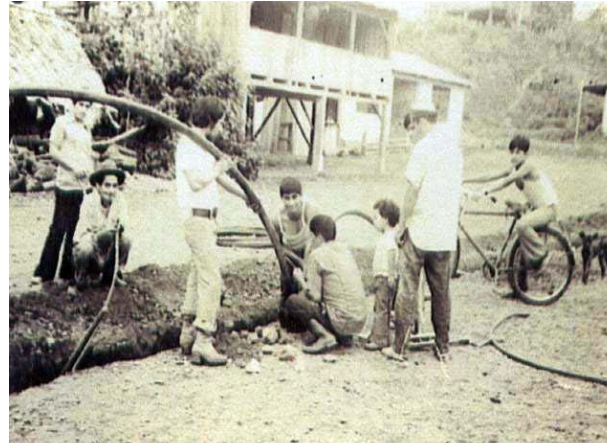
Instalación del agua entubada
