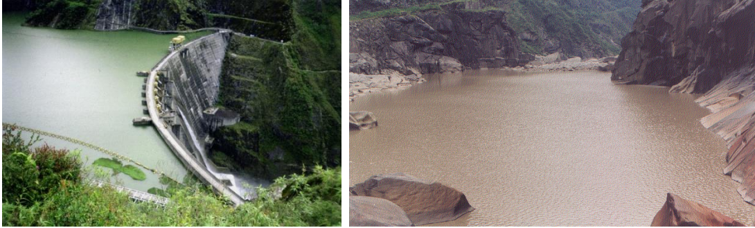
Fotografía 3.11 Presa Daniel Palacios, Proyecto Hidroeléctrico Paute
