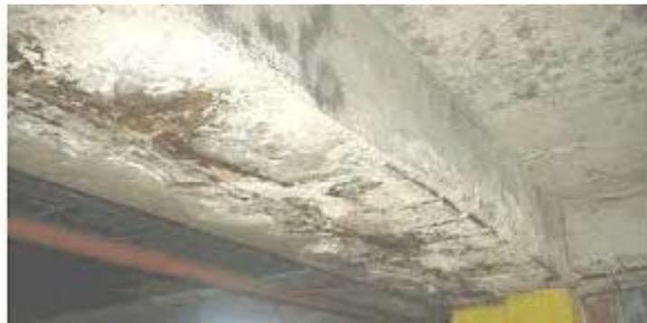
**Ilustración 20. Corrosión del acero**
