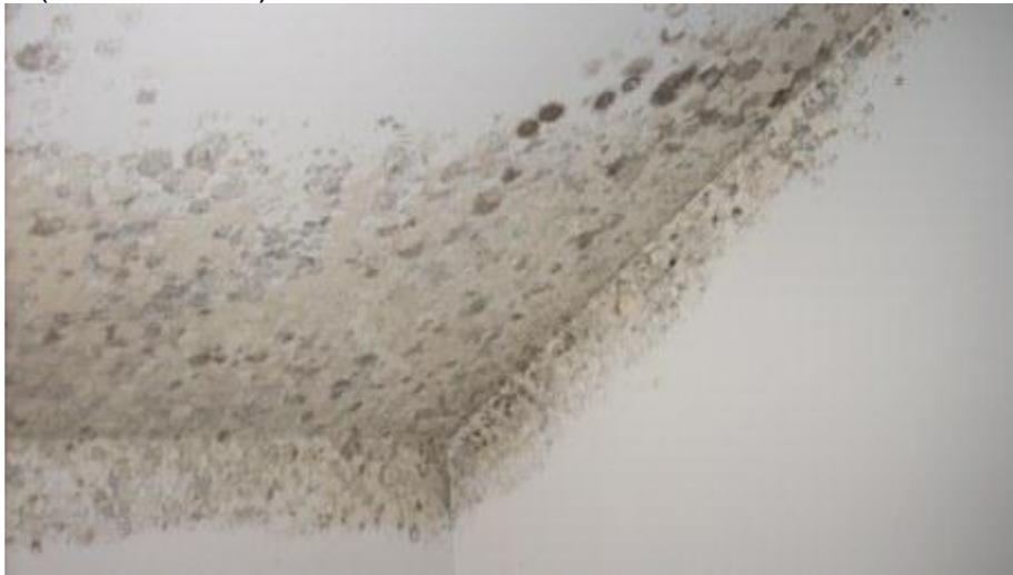
**Ilustración 13. Humedad por infiltración**
