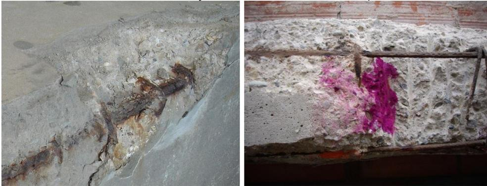
**Ilustración 19. Carbonatación**
