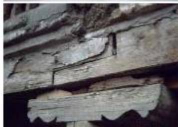
**Ilustración 9. Unión de madera**
