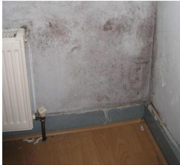
**Ilustración 14. Humedad por condensación**
