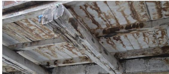
**Ilustración 12. Viga Agrietada**
