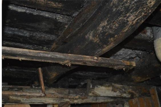
**Ilustración 8. Sección Insuficiente de una viga de madera**
