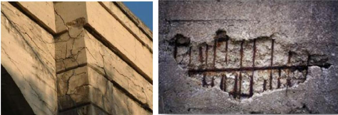
**Ilustración 18. Ataque químico de sulfatos y cloruros**
