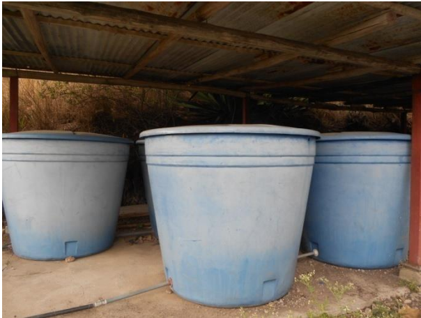
Reservorios de agua.
