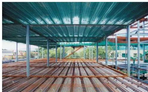
Ilustración 8 Esquema constructivo viga-losa
