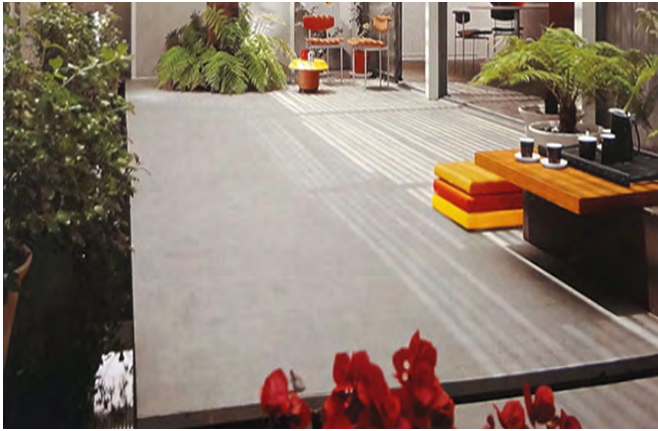
61. Piso de la entrada principal y patio recubiertos con baldosas color beige.
