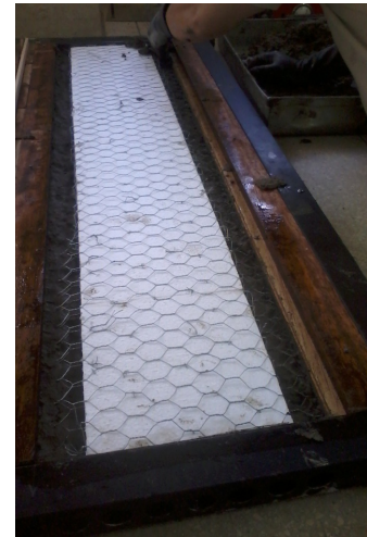
| COLOCACIÓN DE PLACA DE POLIESTIRENO (Imagen 72)
