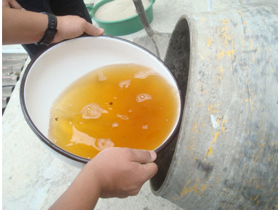
|AGREGAR EL ADITIVO (Imagen 61)
