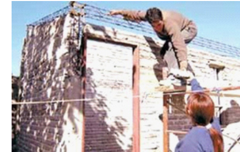
| COLOCACIÓN DE LADRILLO (Imagen 15).
