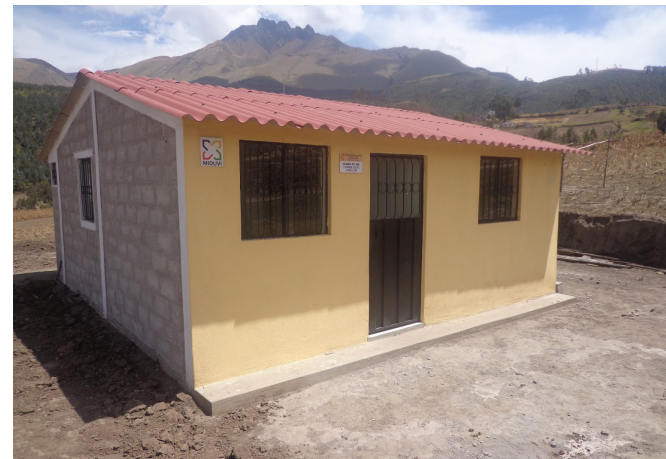
| VIVIENDA RURAL (Imagen 2)
