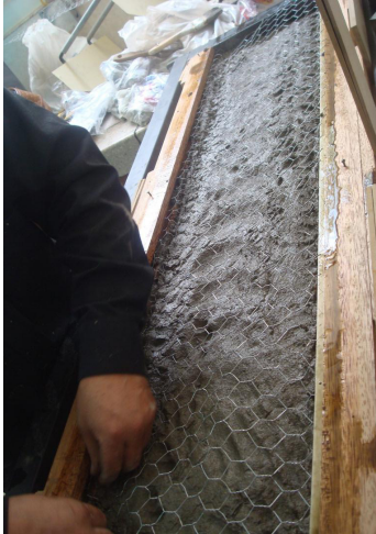
| COLOCACIÓN DE MALLA (Imagen 66)
