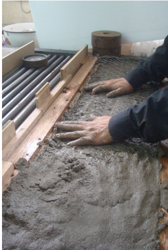
| COLOCACIÓN DE MALLA (Imagen 70)
