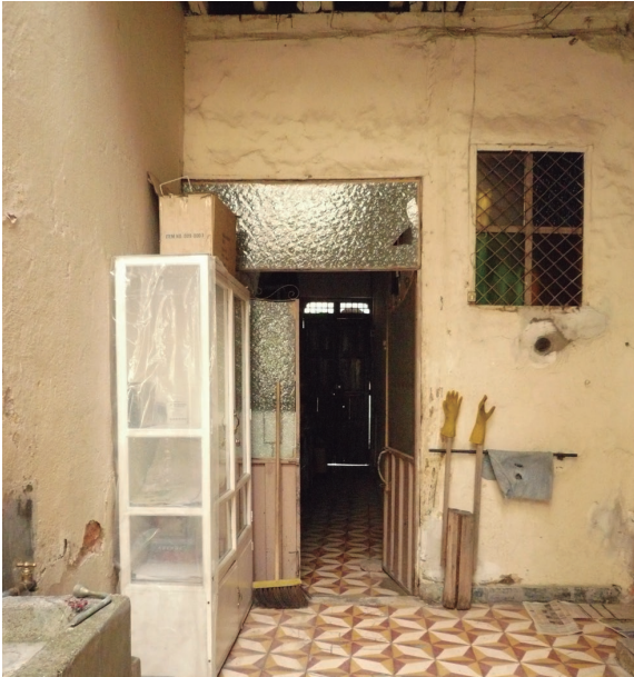
Figura 60 Vista del entorno del patio Fuente: Gabriela Bolaños Sánchez
