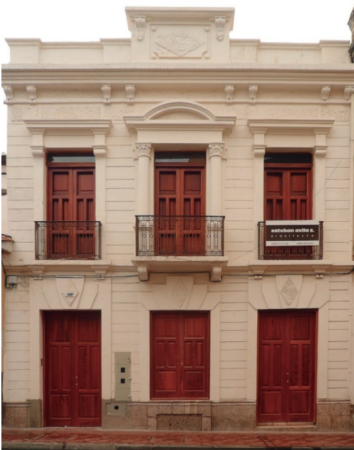
Figura 25. Fachada Frontal de la Casa Serrano-Ullauri
