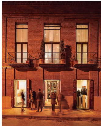
Figura 22. Fachada principal de la casa Juan Jaramillo
