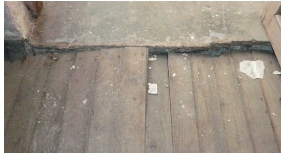
Figura 68 Piso de la habitación 1 Planta Baja Fuente: Gabriela Bolaños Sánchez
