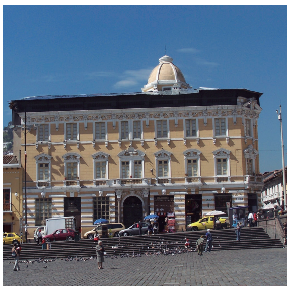
Figura 12. Fachada de la Casa Gangotena antes de la intervención
