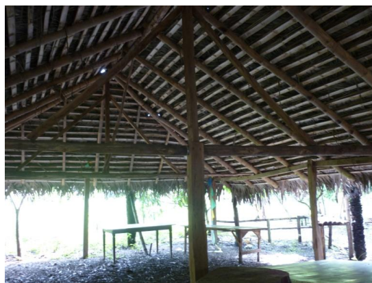
Figura 6.1 Detalle de cubierta Fuente: Fotografía de la autora
