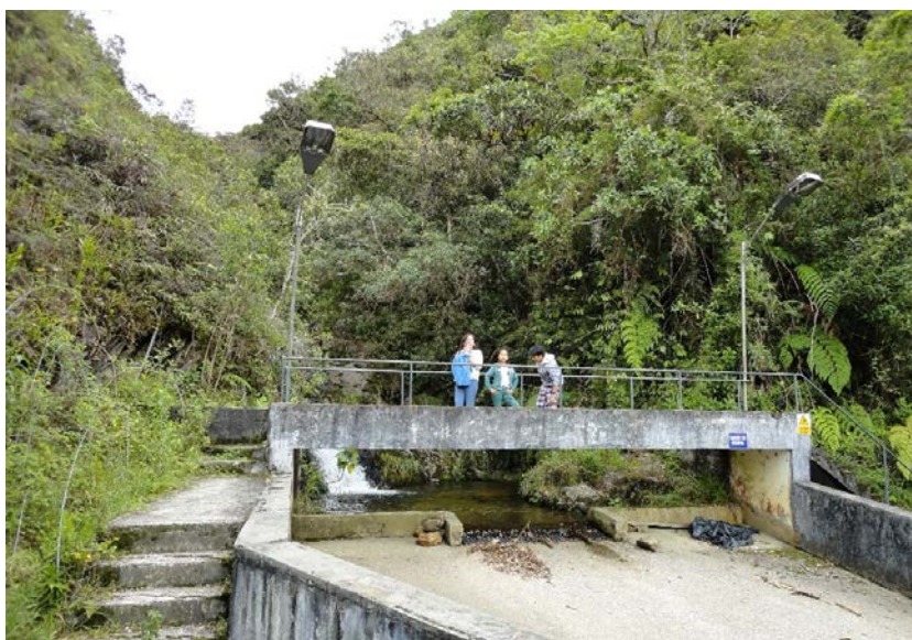
Figura 1.6 Captación de la quebrada Milagros. Fuente propia
