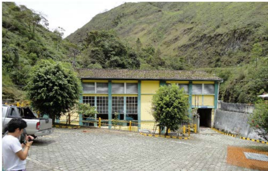
Figura 1.10 Casa de Máquinas. Fuente propia
