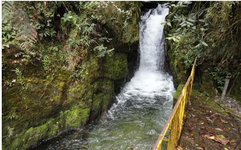
Figura 1.7 Captación San Ramón. Fuente propia
