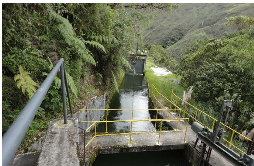
Figura 1.8 Tanque de presión de San Francisco. Fuente propia
