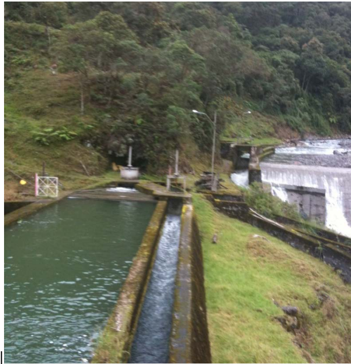
Figura 1.5 Captación principal del río San Francisco. Fuente propia
