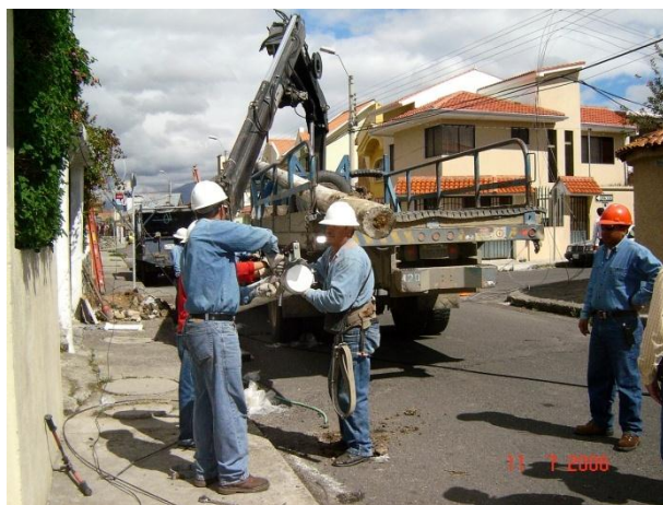
Figura 3.7 Cuadrilla No 2, designada para el transporte e izado de postes con máquina
