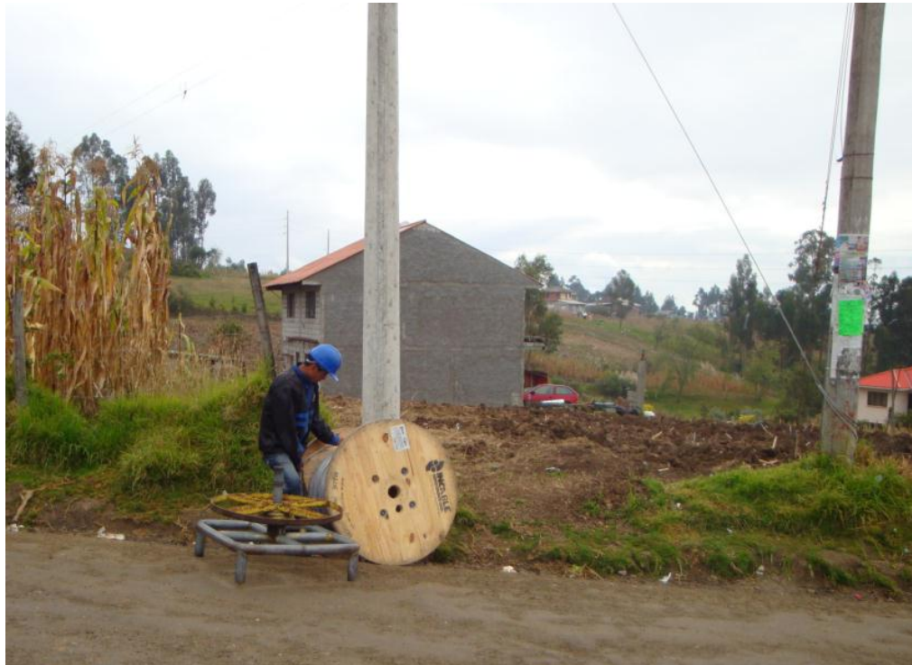
Figura 3.16 Armado de la desenrolladora, como paso previo al tendido de conductor
