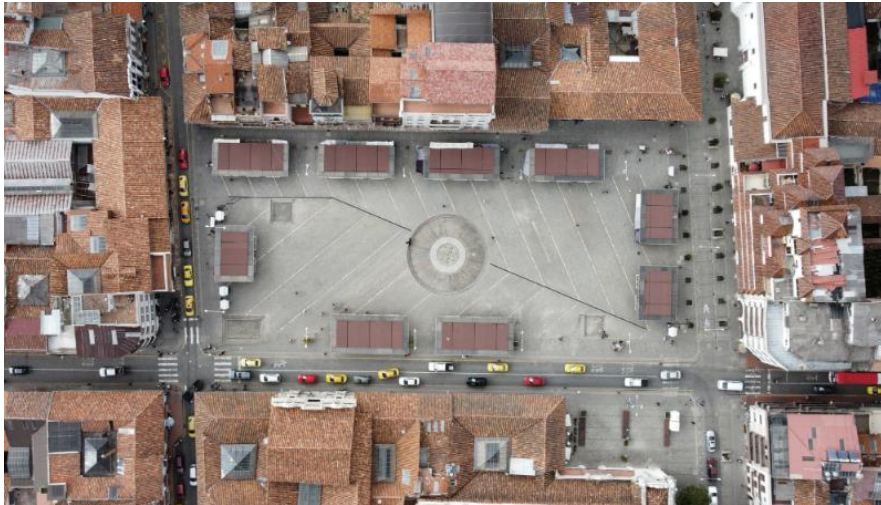
Figura 85. Emplazamiento Plaza San Francisco
