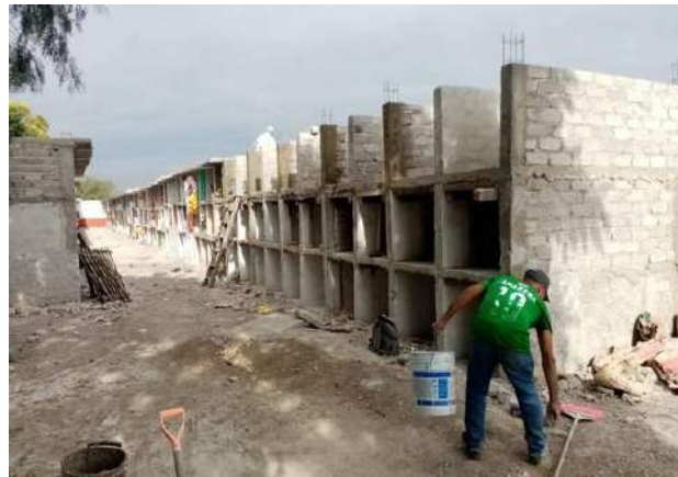
Imagen 18: Gavetas en un cementerio municipal Fuente: Delgado Manuel (México, 2020), Construcción de 30 nuevas gavetas en Panteón Municipal.
