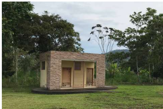
Imagen 66: Baños públicos del Cementerio Fuente: Propia
