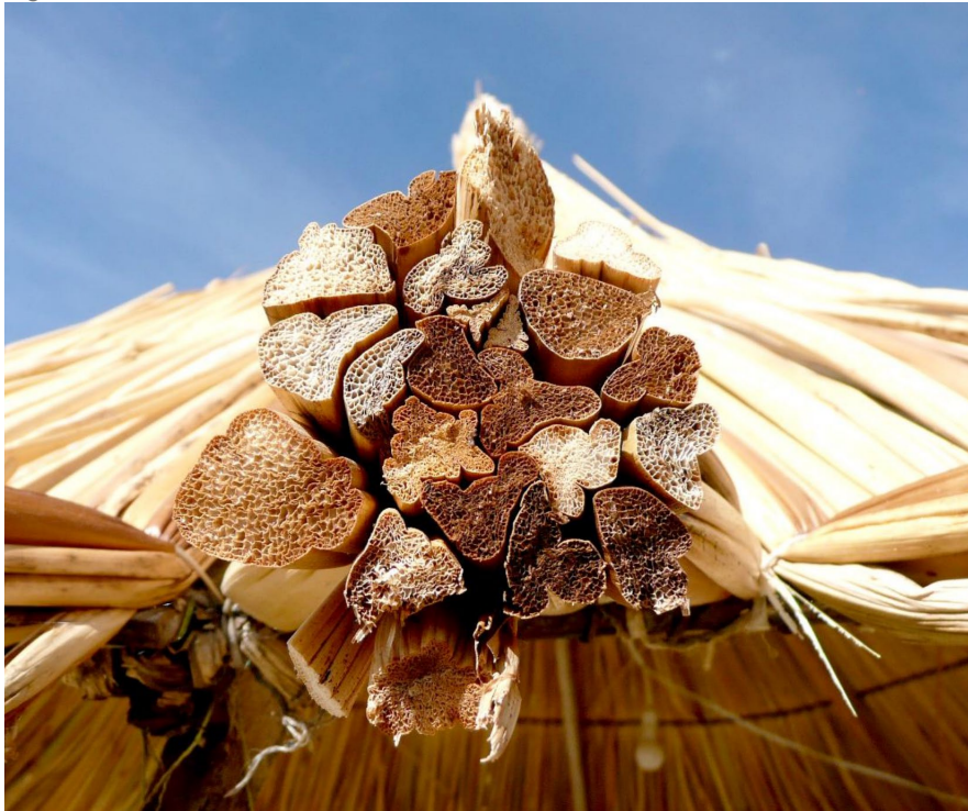
Figura 06. Detalle de cubierta de totora.
