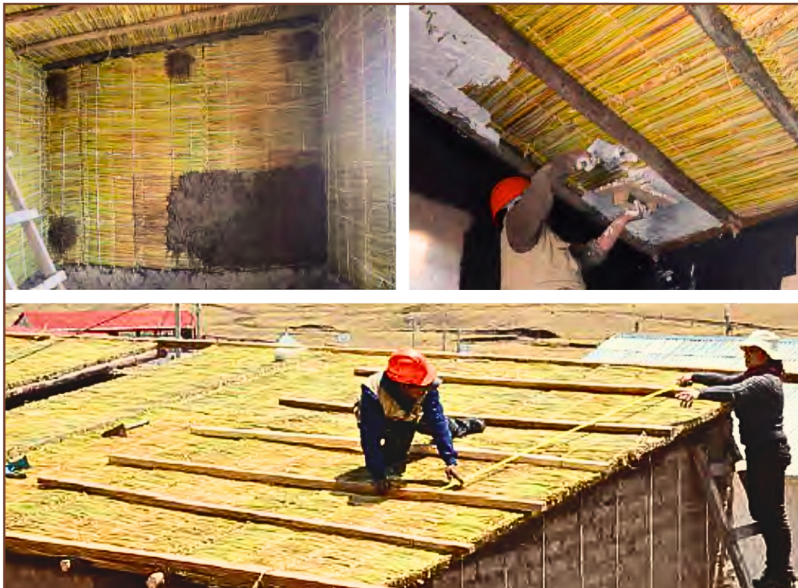
Figura 16: Colchones de totora en cubiertas y muros del proyecto abrigando hogares en Puno, Perú.
