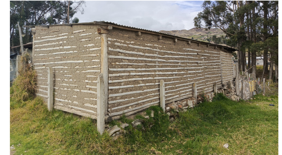
Figura 77: Vivienda vernácula sin revestimiento, latillas de cañas vistas
