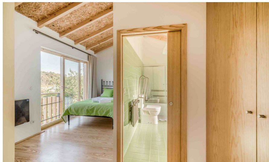
Figura 84: Cubierta con tableros OSB. Quinta do Fortunato
