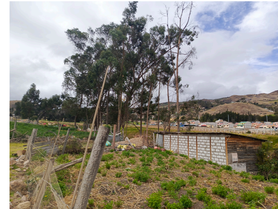
Figura 15: Construcción rural con bloque de cemento visto. Sector Iza Vieja, Cañar
