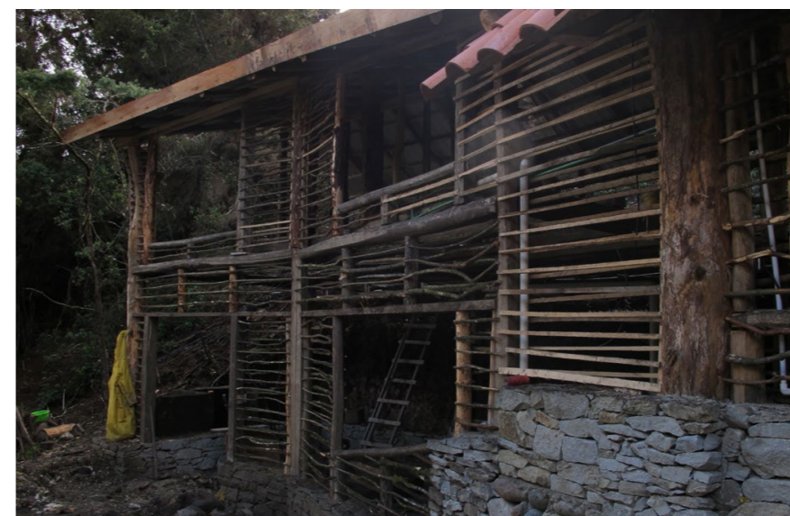
Figura 82: Entramado de ramas y retazos de madera Fuente: Manual para la autoconstrucción de una vivienda. Pablo Cardoso
