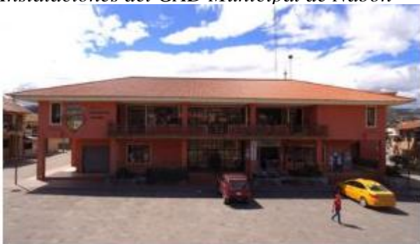
Instalaciones del GAD Municipal de Nabón
