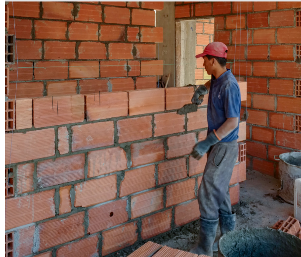
Figura 1.8.27 MAMPOSTERÍA DIVISORIA CON LADRILLO TOCHANO - ALTAVISTA III (2019)
