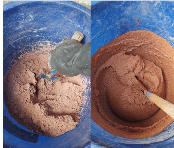
Figura 3 .2 Mezcla del mortero - relación 2:3.
