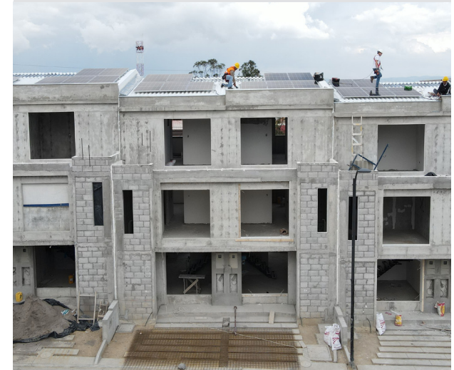
Figura 1.8.29 Mampostería de bloque - Proyecto residencial Bellavista (2023)
