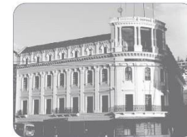
15 Vivienda del Sr. José María Arteta Actual Dirección de Movilización de las Fuerzas Armadas Diseño 1925 - 1929
