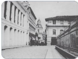
6 Pavimentación de calles, plazas y construcción de puentes Dirección de obra 1897 - 1912
