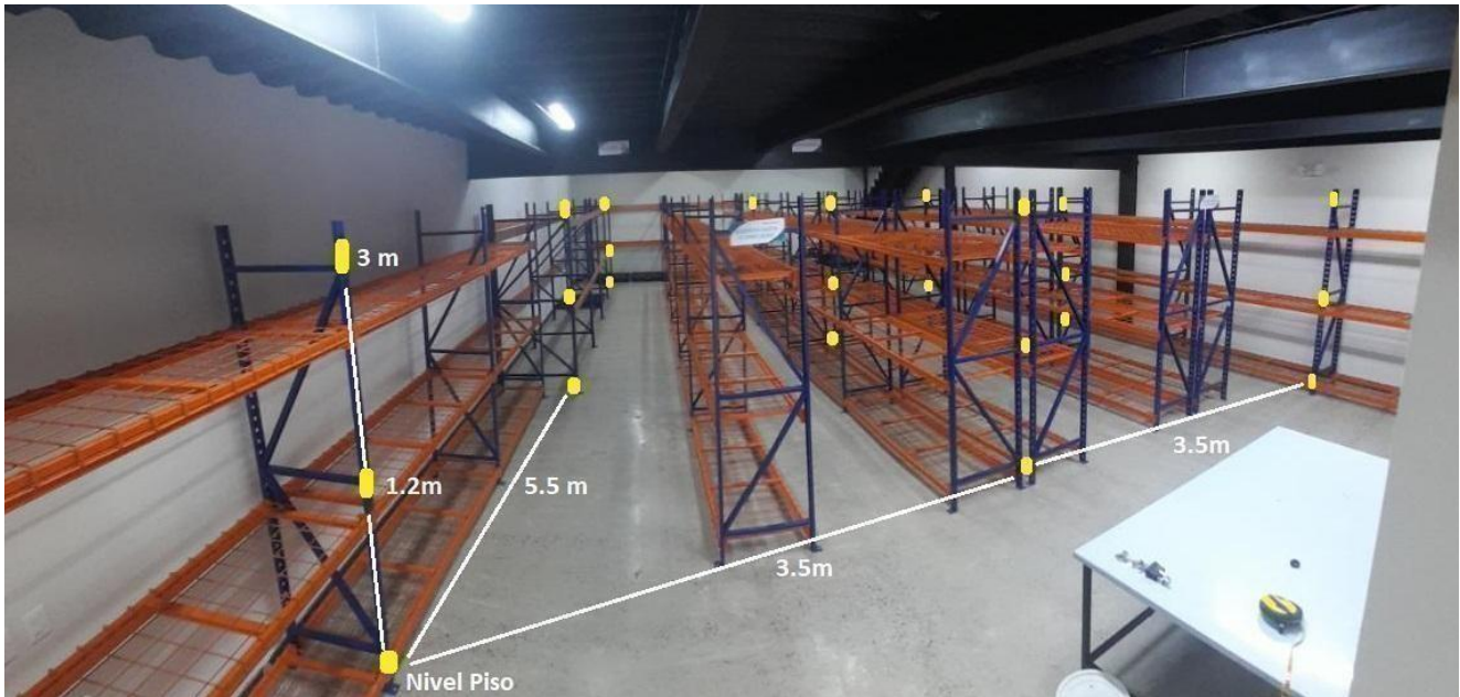
Figura 1. Bodega Planta Baja con ubicación de datalogger en los racks
