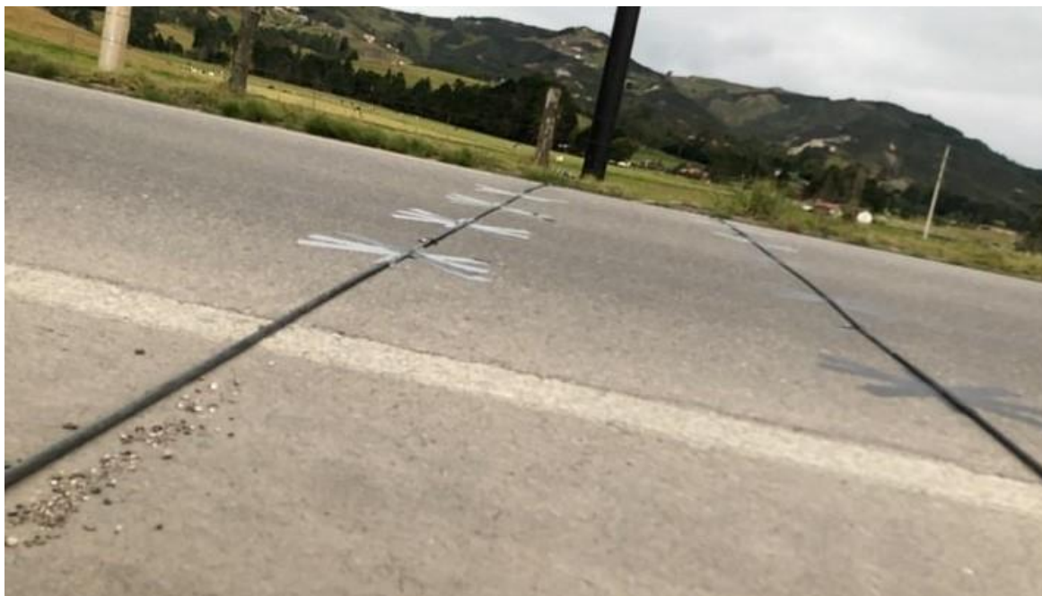
Sujeción de mangueras neumáticas a la calzada.
