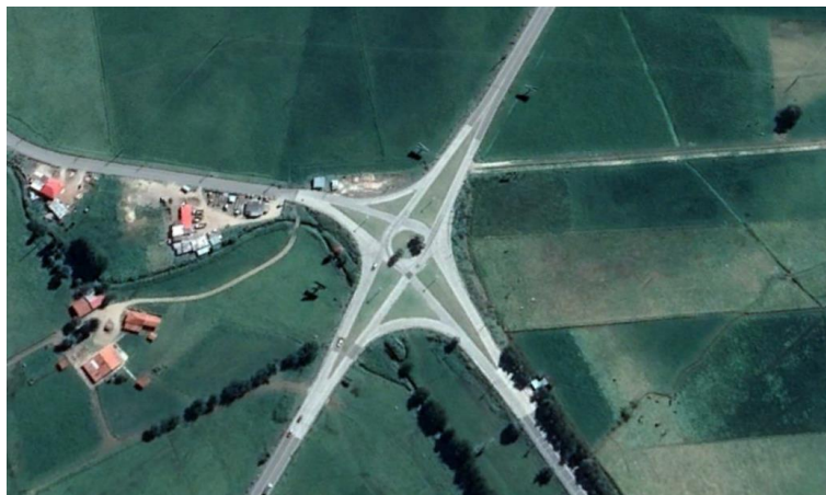
Figura 13. Intersección Redondel de Cumbe.
