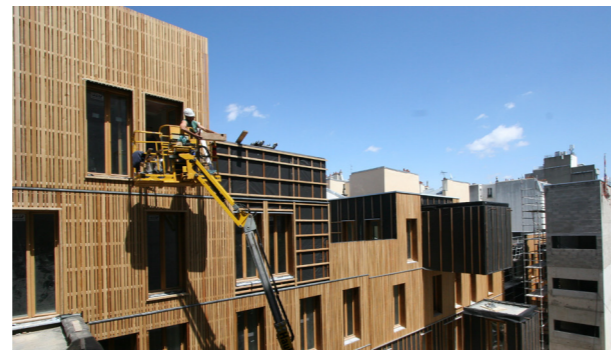
Figura 2.62: Colocación de paneles de madera Fuente: Plataforma arquitectura
