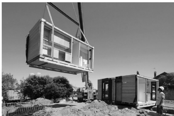
Figura 1.20: Vivienda prefabricada e industrializada Fuente: Cámara chilena de la construcción, 2022
