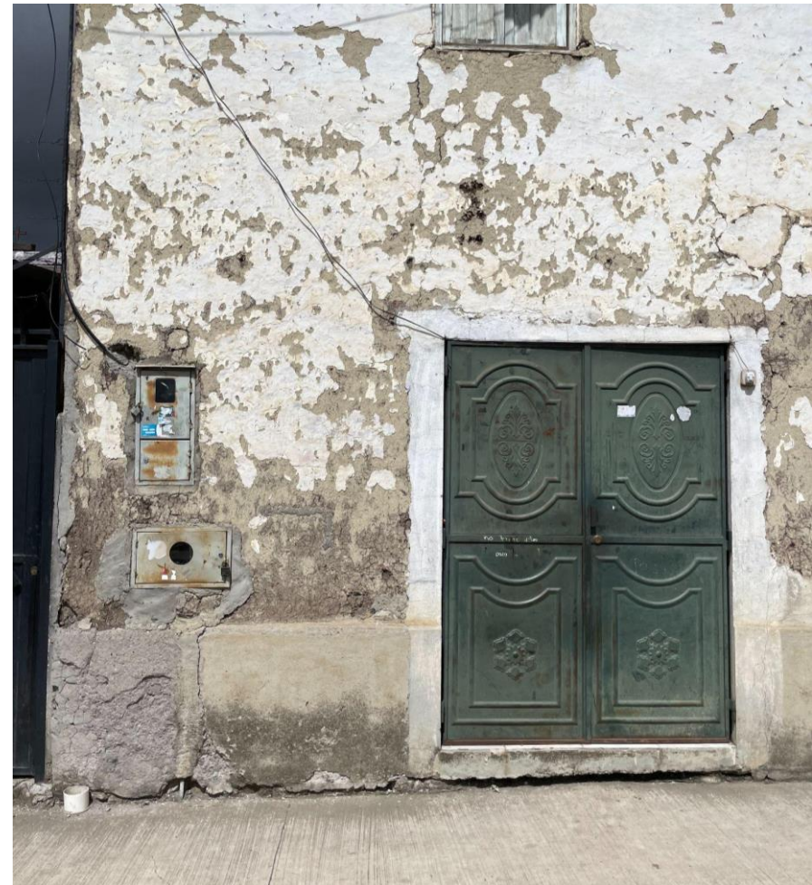
Fig. 105. Ingreso principal edificación del Sr. Mauro Pilco
