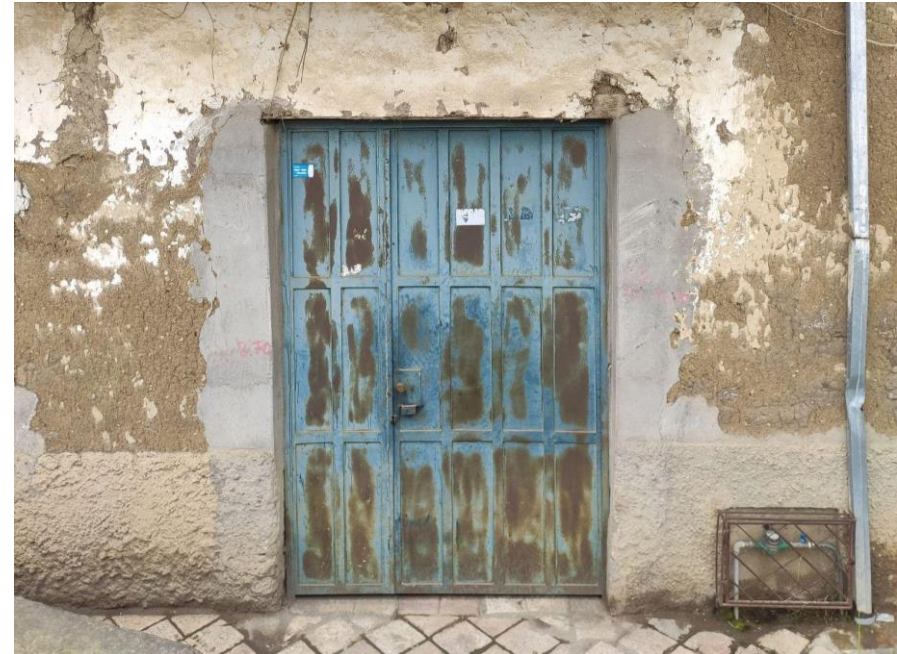
Fig. 112. Ingreso principal edificación del Sr. Roberto Villacis
