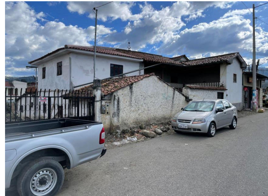
Fig. 96. Fachada lateral, edificación del Sr. Iván Vega
