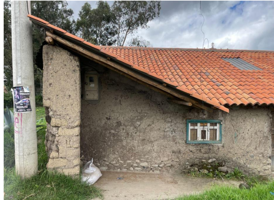
Fig. 90. Muro lateral izquierdo
