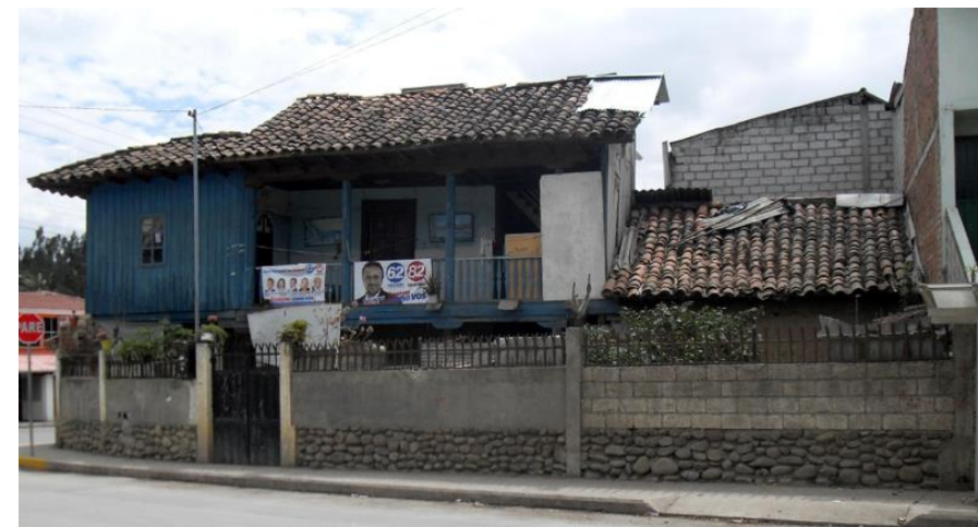
Fig. 142. Edificación de madera en la Av. Carlos Arízaga Vega
