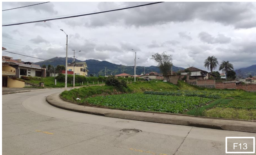
Fig. 63. Tramo 3: Ingreso Av. Carlos Arízaga Vega
