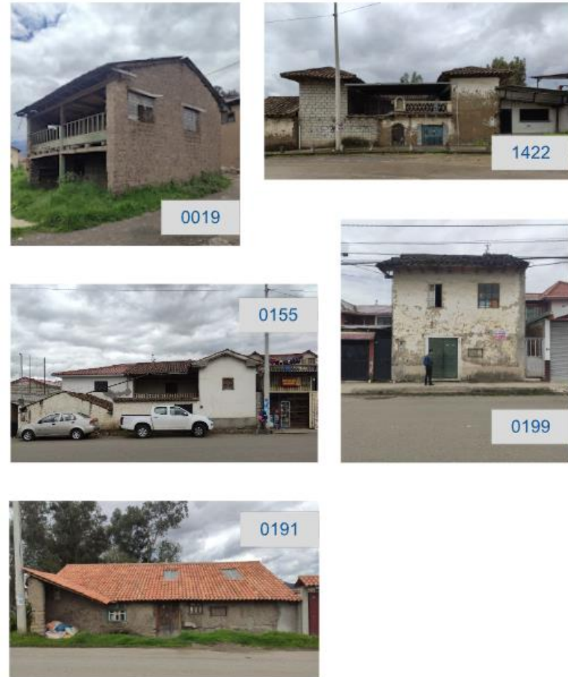
Fig. 82. Fotografía de edificaciones seleccionadas para aplicar la ficha de Registro
