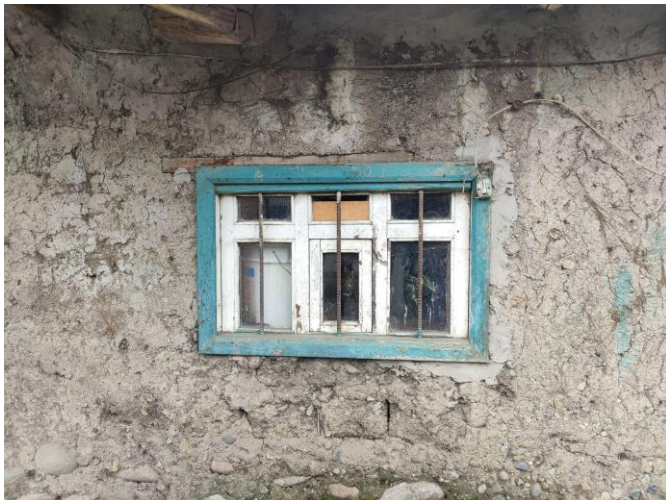
Fig. 89. Ventana edificación de la Sra. Nelly Pulla
