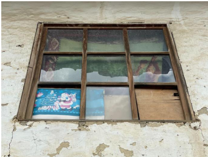
Fig. 104. Ventana edificación del Sr. Mauro Pilco
