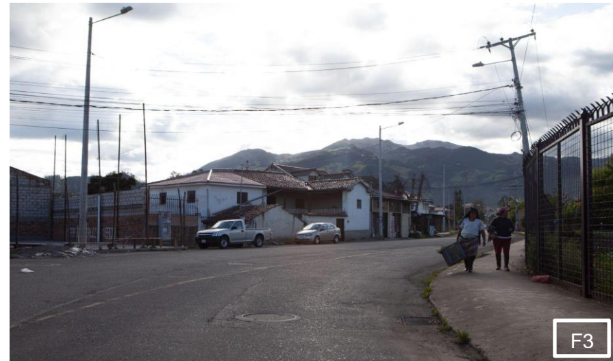
Fig. 58. Tramos 1: Av. Carlos Arízaga Vega
