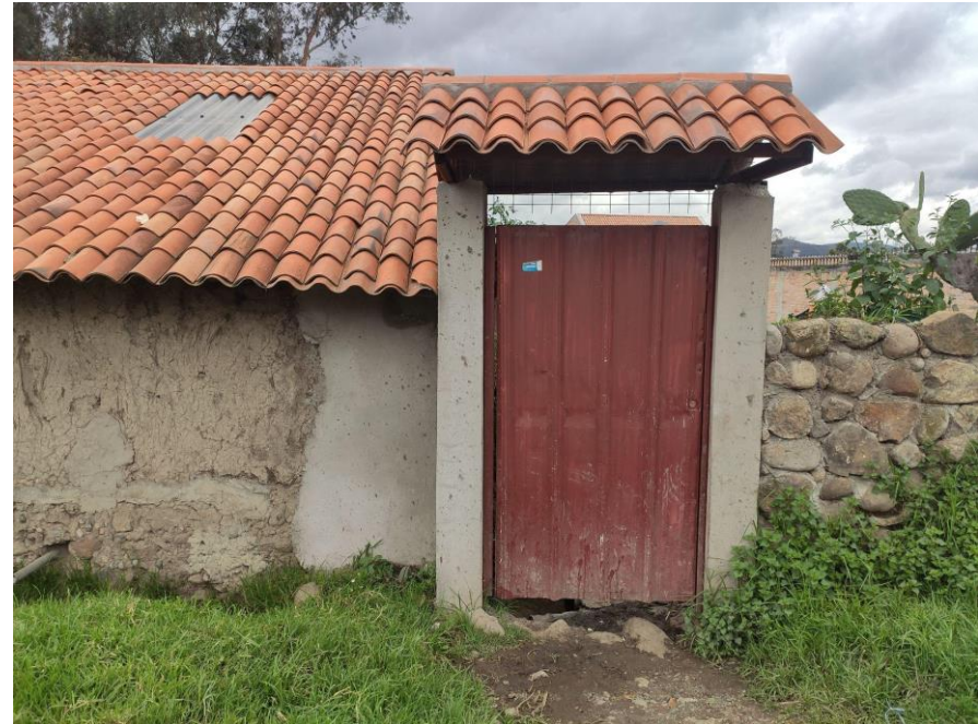
Fig. 88. Ingreso secundario edificación de la Sra. Nelly Pulla
