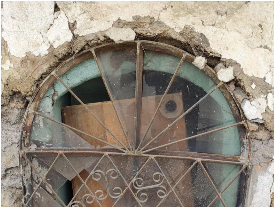
Fig. 111. Ventana edificación del Sr. Roberto Villacis
