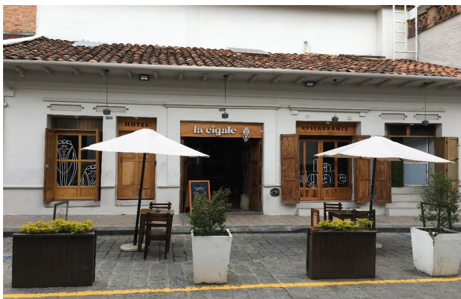
Fachada frontal del restaurante La Cigale
