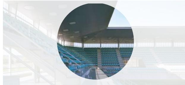
Cubierta de estructura metálica con falso techo
